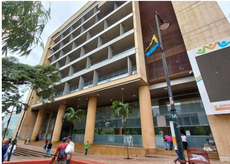
Figura 1 Fotografía del edificio de la Gobernación del Meta en la ciudad de Villavicencio.
