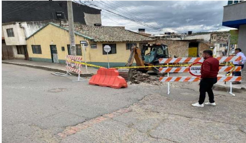
Figura 8. Inspección vía barrio La Florida.
