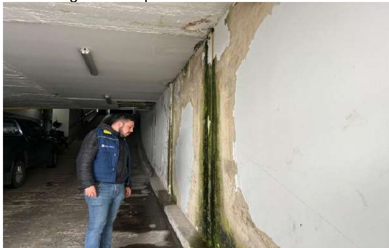
Figura 9. Inspección muro edificio DIAN.
