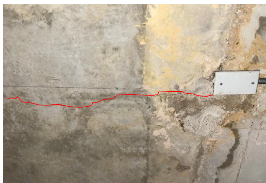
Foto 2. Placa entrepiso nivel +1,25 sótano 1
