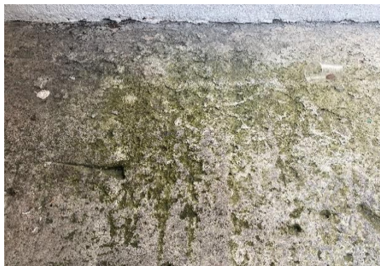
Foto 3. Placa parqueaderos nivel +1,25 piso 1
