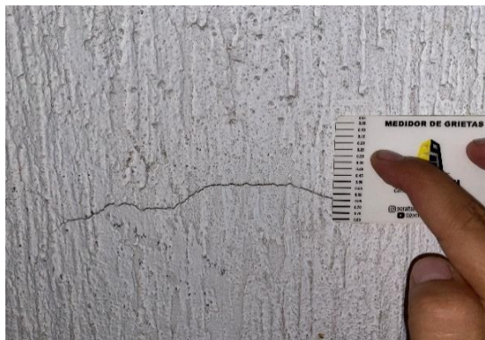
Foto 3. Muro no estructural escalera
