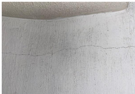
Foto 2. Muro no estructural escalera
