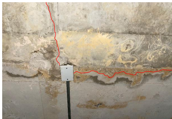
Foto 3. Placa entrepiso Nivel +1,25 sótano 1
