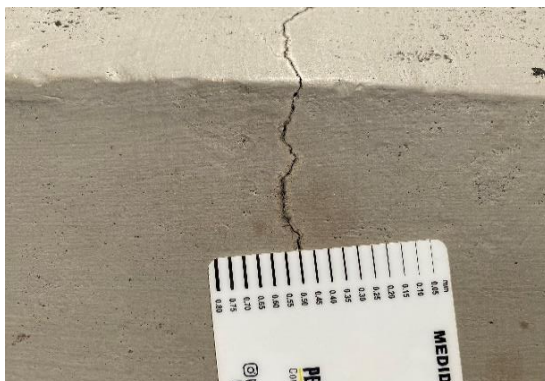
Foto 3. Alfajías en concreto parque infantil piso 2
