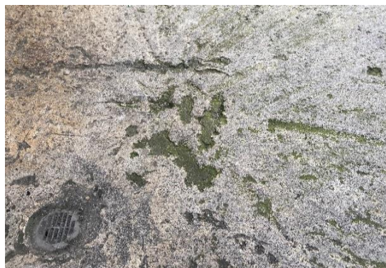
Foto 2. Placa parqueaderos nivel +1,25 piso 1
