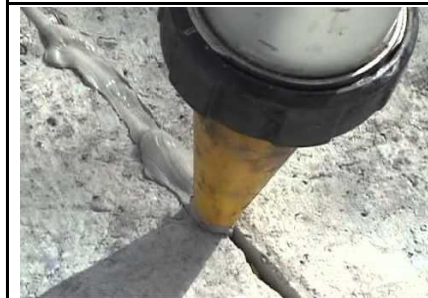
Foto 4. Ejemplificación de inyección de fisuras por medio de un sellante epoxico.
