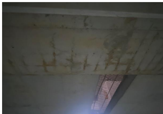
Foto 3. Viga VG-E placa nivel +1,25 sótano 1
