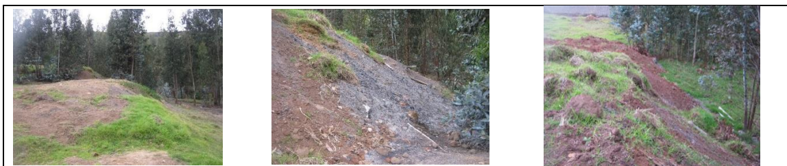
Figura 8. Registro fotográfico de la situación encontrada
