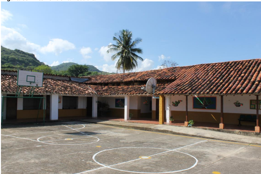
Figura 65. Interior de la Escuela
