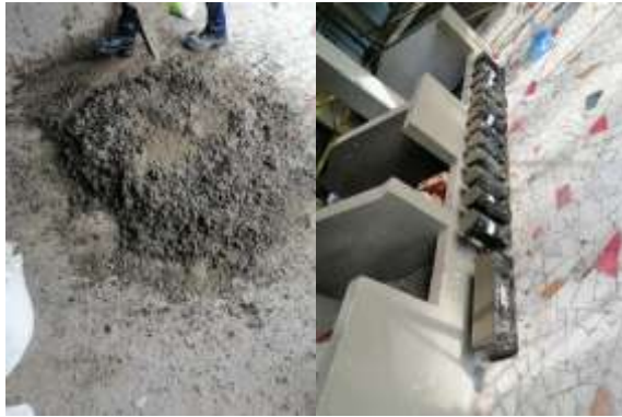
Figura 27 Mezcla concreto normal.
