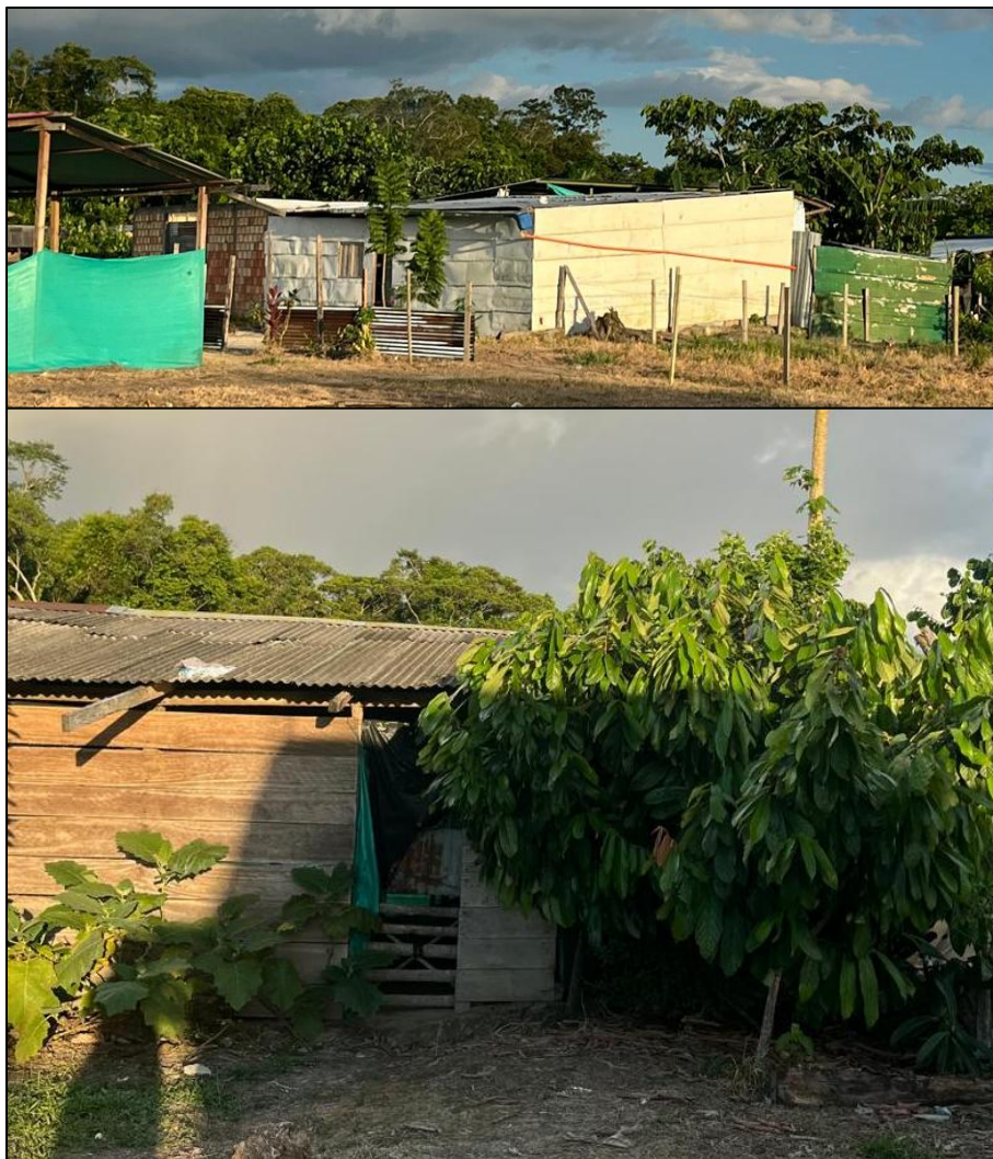
Figura 2. Casas en autoconstrucción, predio Providencia.
