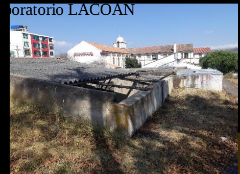
Figura 16. Foto levantamiento topográfico 3. Fuente: Elaboración propia.
