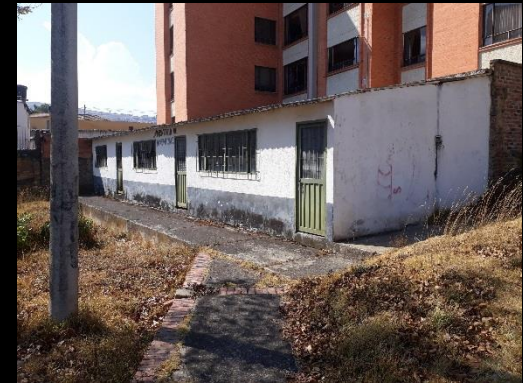
Figura 15. Foto levantamiento topográfico 2. Fuente: Elaboración propia.
