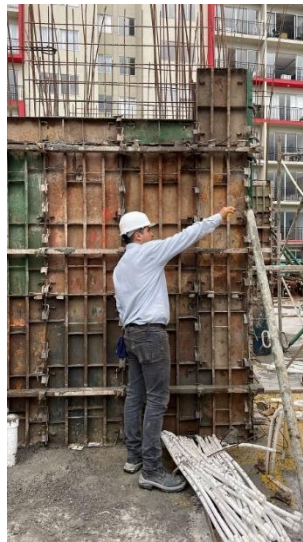
Figura 4.3 Verificación del correcto aplomado de columnas y pantallas.
