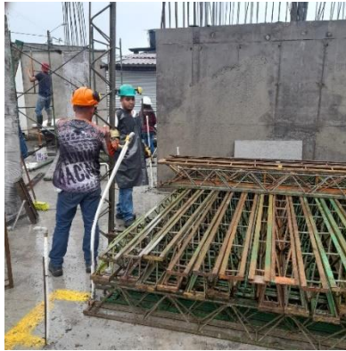
Figura 4.4 Aprovechamiento de formaleta para armadura de placas de entrepiso.
