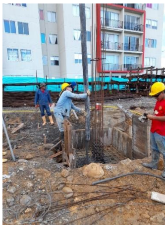
Figura 4.1 Inspección de vaciado de concreto en zapatas de cimentación.
