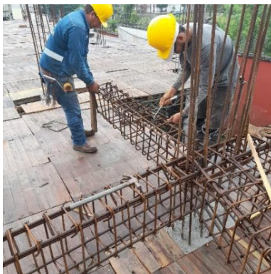
Figura 4.2 Seguimiento al proceso de amarre de acero de refuerzo en vigas de entrepiso.
