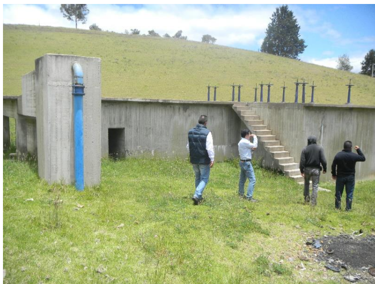
Ilustración 3. PTAP existente en el Municipio de Santa Rosa de Viterbo.
