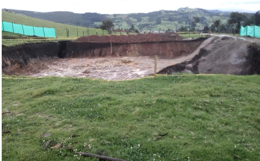
Ilustración 5. Excavación para el tanque de almacenamiento en la PTAP de Santa Rosa de Viterbo.
