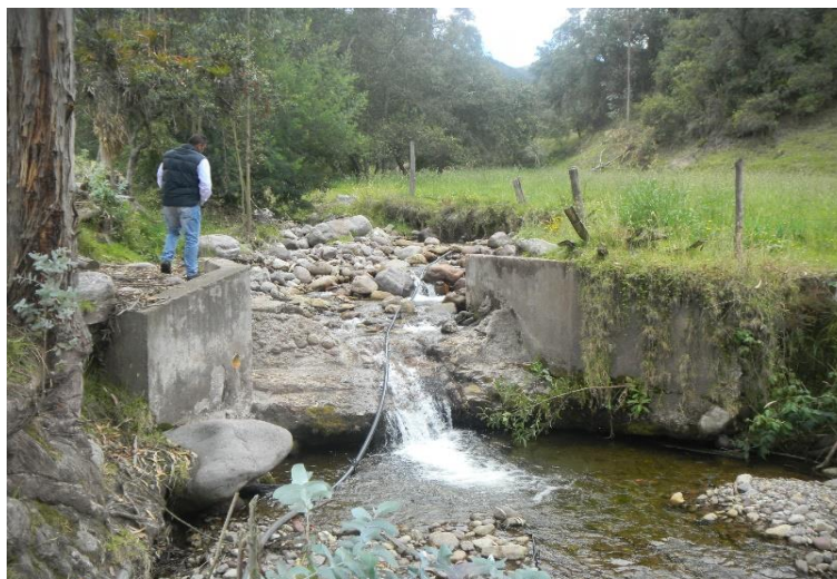
Ilustración 1. Bocatoma existente en el acueducto del Municipio de Santa Rosa de Viterbo.
