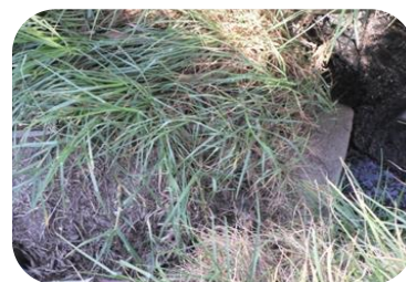
Descarga # 3 Potrero – Tubería Concreto D = 16"
