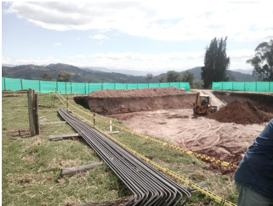
Ilustración 6. Excavación de tanque de almacenamiento en la tercera visita técnica.
