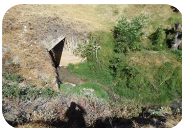
Descarga # 2 Quebrada la Carbonera – Canal Abierto
