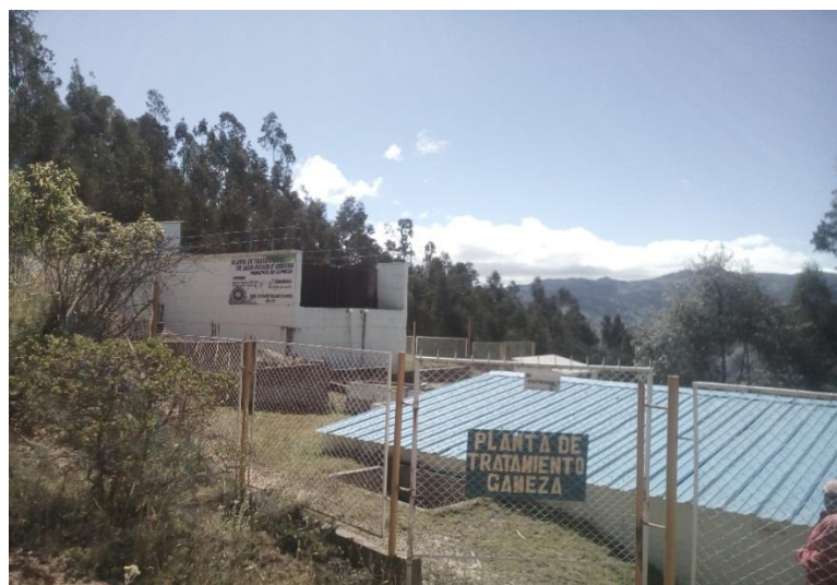
Ilustración 19. Cerramiento y señalización en la PTAP.
