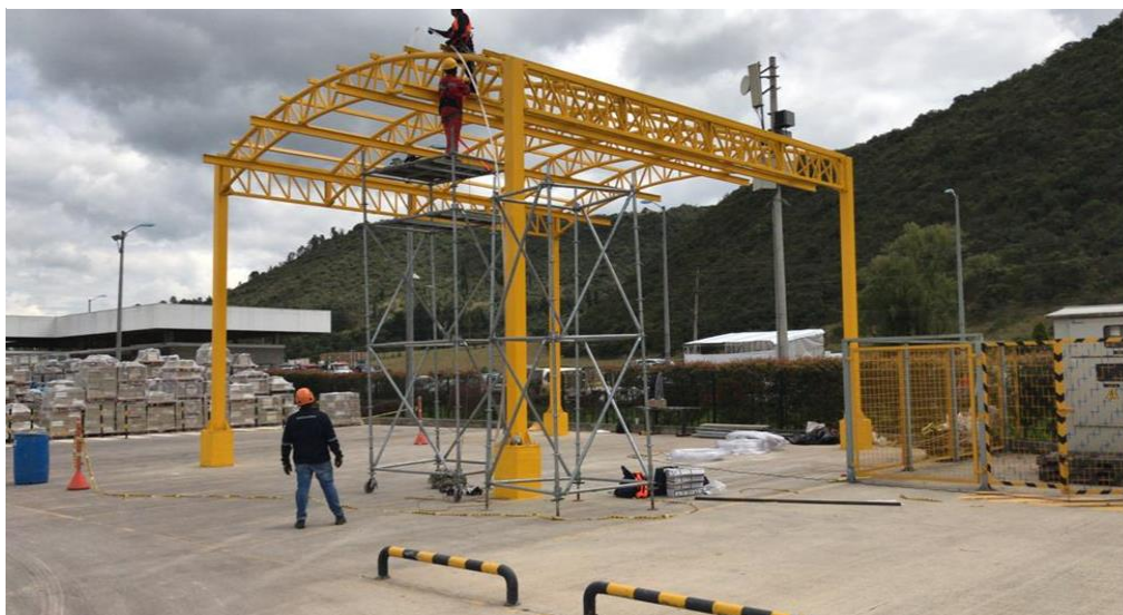
Figura 513. Instalación de carpadero en Cerámicas San Lorenzo mediante el uso de andamios
