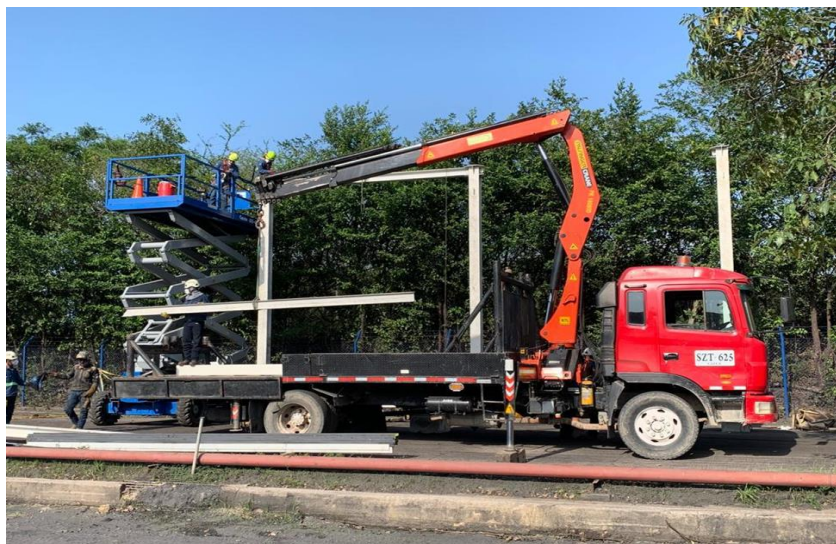
Figura 1. Instalación de capadero mediante uso de PEMP
