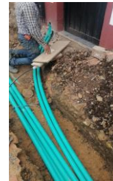
Figura 13 Instalación de tubería eléctrica
