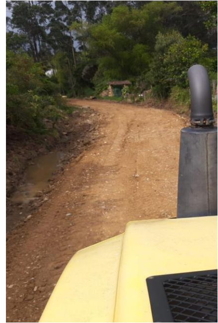
Figura 35 Compactación del afirmado
