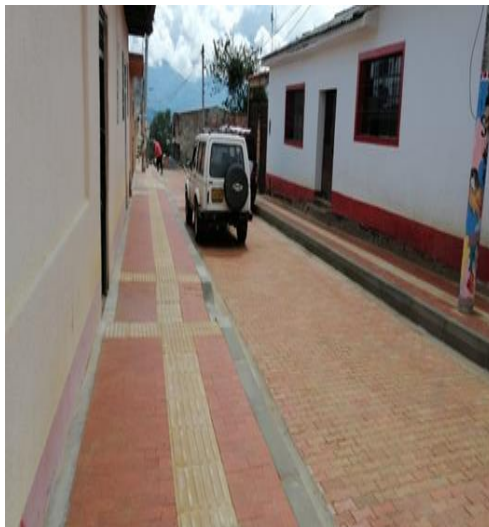
Figura 14 Terminación de la obra
