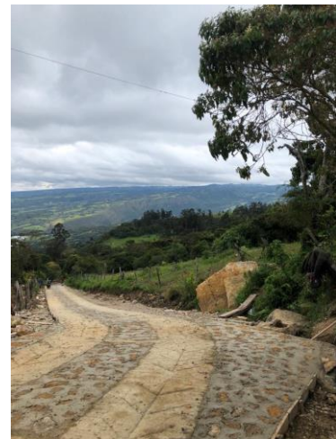
Figura 51 Segundo tramo de cinta huella Pantanillo
