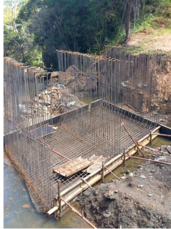
Figura 19 Amarado de acero estructural
