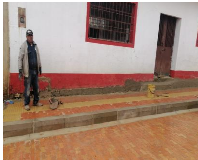
Figura 12 Instalación de adoquín
