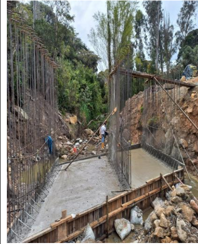
Figura 20 Fundición de placa piso
