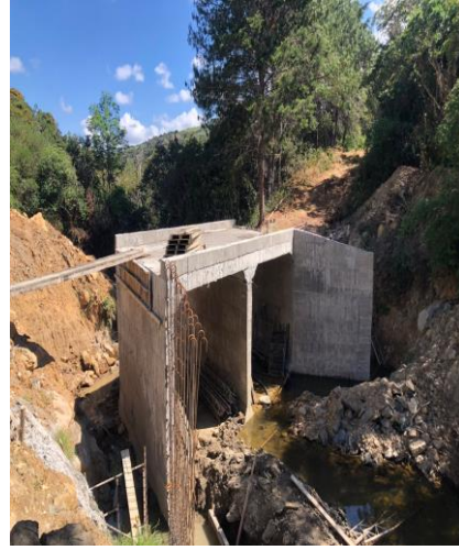
Figura 22 Fundición placa y aletas
