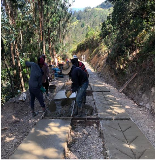
Figura 42 Vaciado del concreto clase G
