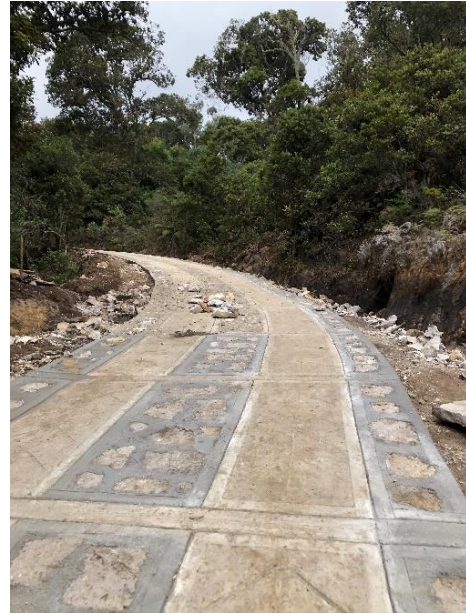
Figura 45 Colocación de la piedra pegada
