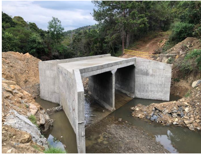
Figura 23 Terminación de la obra
