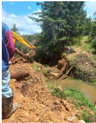
Figura 16 Demolición del puente existente
