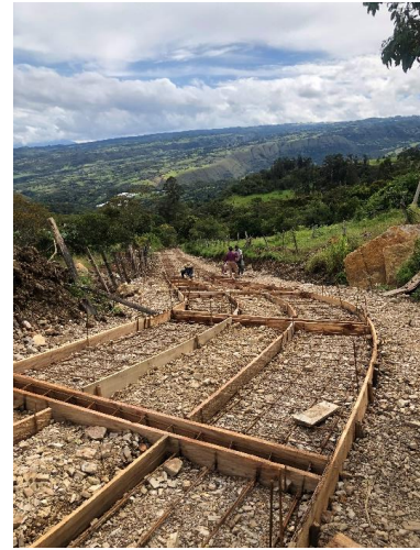
Figura 41 Figurado de acero estructural
