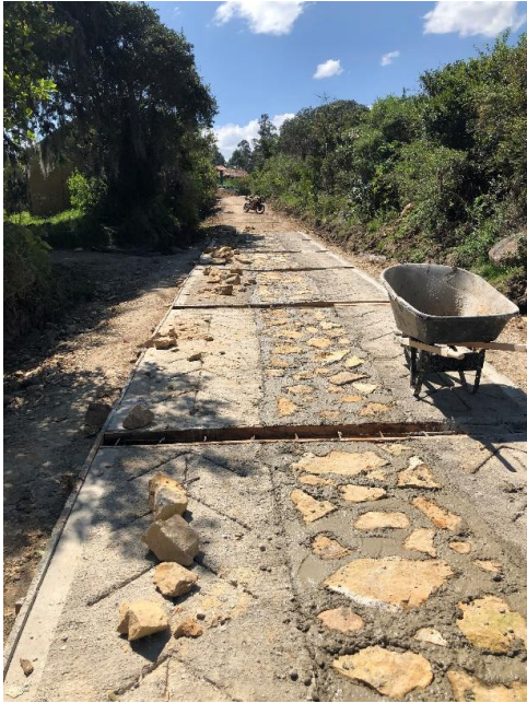
Figura 44 Fundición de concreto ciclópeo
