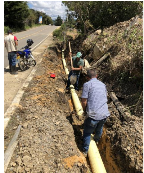
Figura 28 Instalación de tubería
