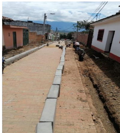
Figura 10 Instalación de sardinel
