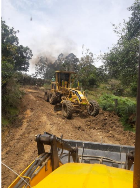
Figura 34 Intervención de la Vía
