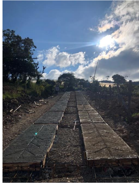
Figura 43 Conformación de la Vía
