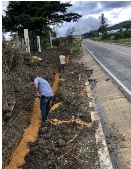
Figura 27 Relleno de material
