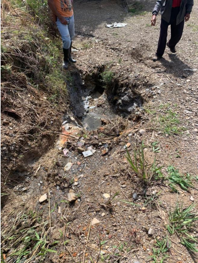
Figura 4 Inspección ocular zanjas de escorrentía
