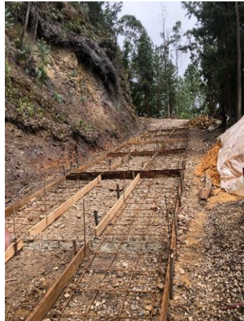
Figura 40 Encofrado
