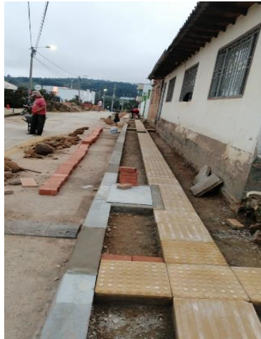
Figura 11 Instalación de Loseta
