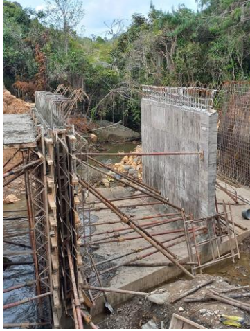
Figura 21 Fundición primer muro estructural
