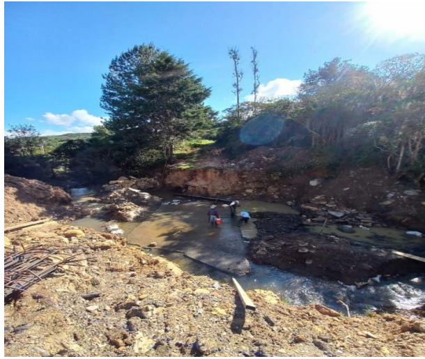
Figura 18 Vaciado del concreto
