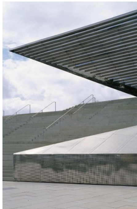
Figura 18. Cubierta del estadio en Francia
