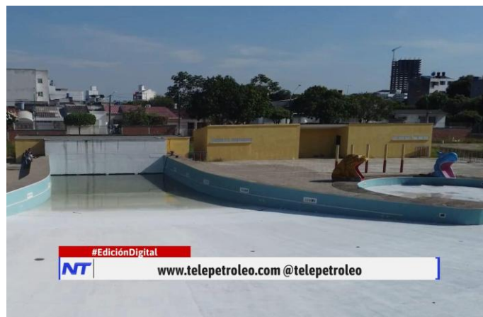
Figura 9. Imagen del parque del agua, vista desde el interior
