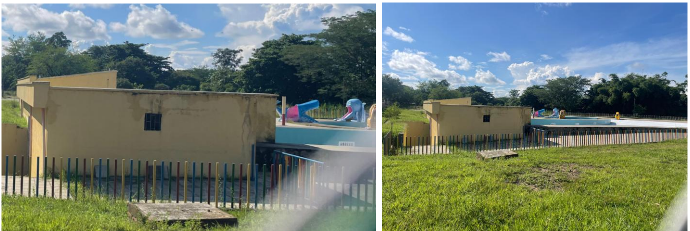
Figura 34. Fotografía del lote actualmente, con edificación sin culminar
