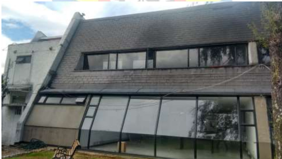
Imagen 2. Fachada Posterior Bloque 1 Fuente: Autor
