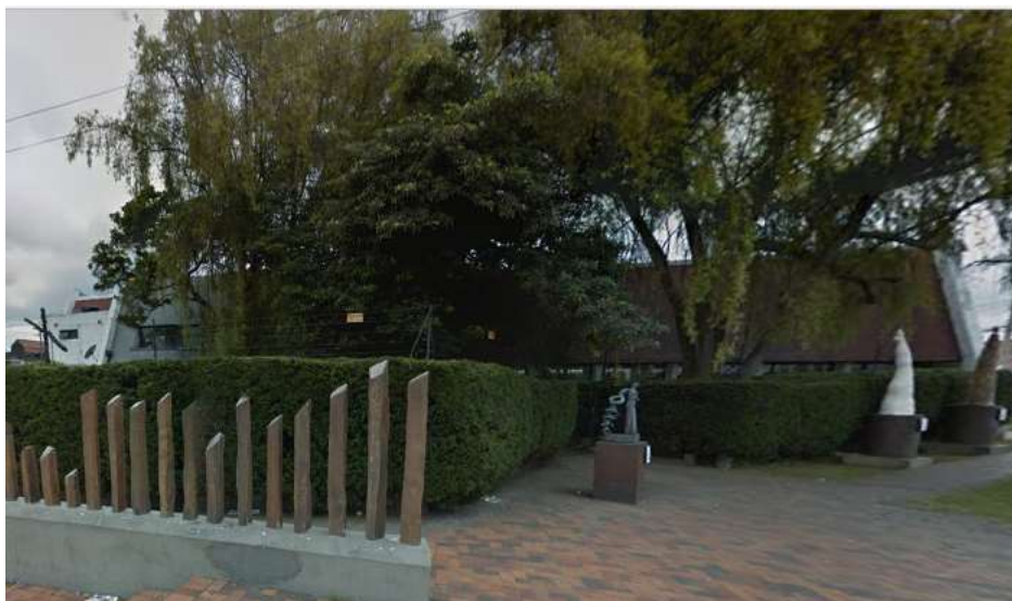
Imagen 32. Fachada Posterior Fuente: Autor
