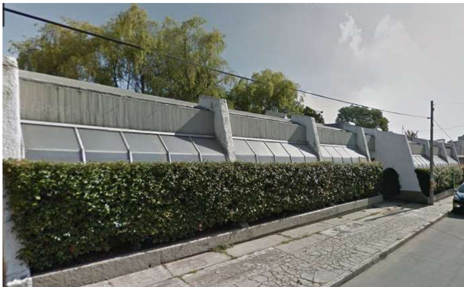
Imagen 31. Fachada Principal Sobre Calle 81A
