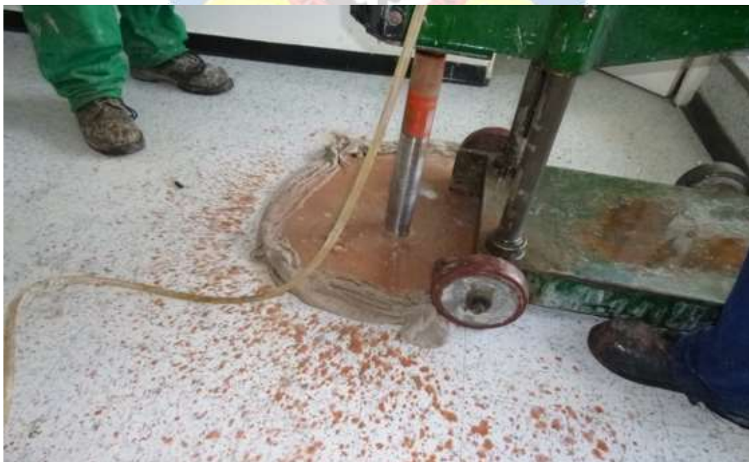
Imagen 53. Extracción de Núcleo de Concreto NC-2 Fuente: Autor
