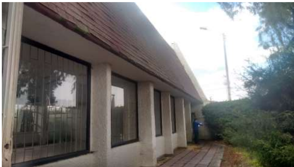
Imagen 3. Fachada Posterior Bloque 2 Fuente: Autor
