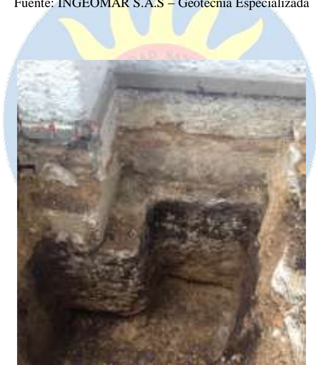
Imagen 41. Detalle de Cimentación Apique AP-6 Fuente: Autor
