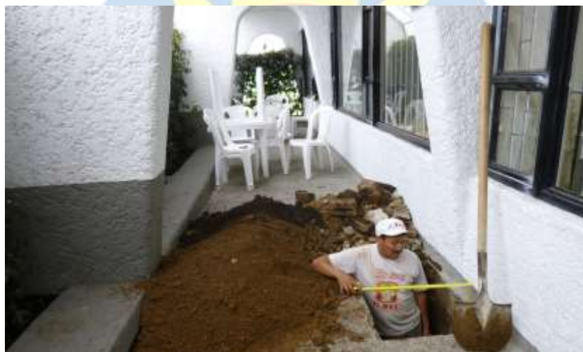
Imagen 39. Apique a mano exploración cimentación
