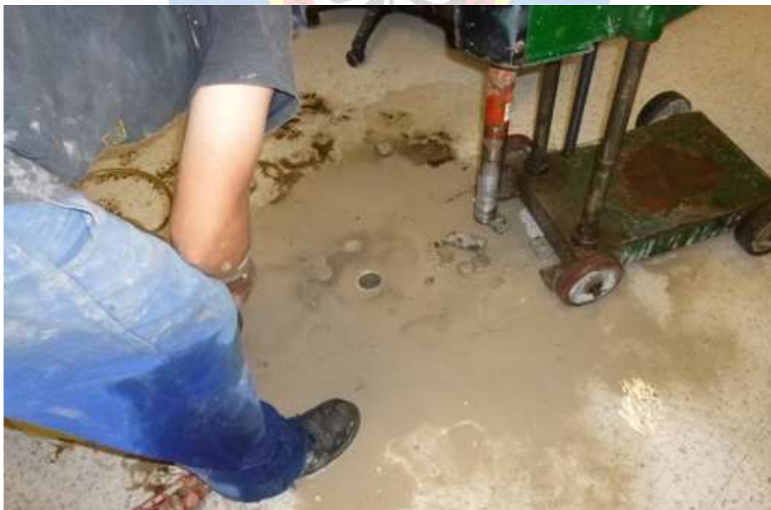
Imagen 51. Extracción de Núcleo de Concreto NC-1
