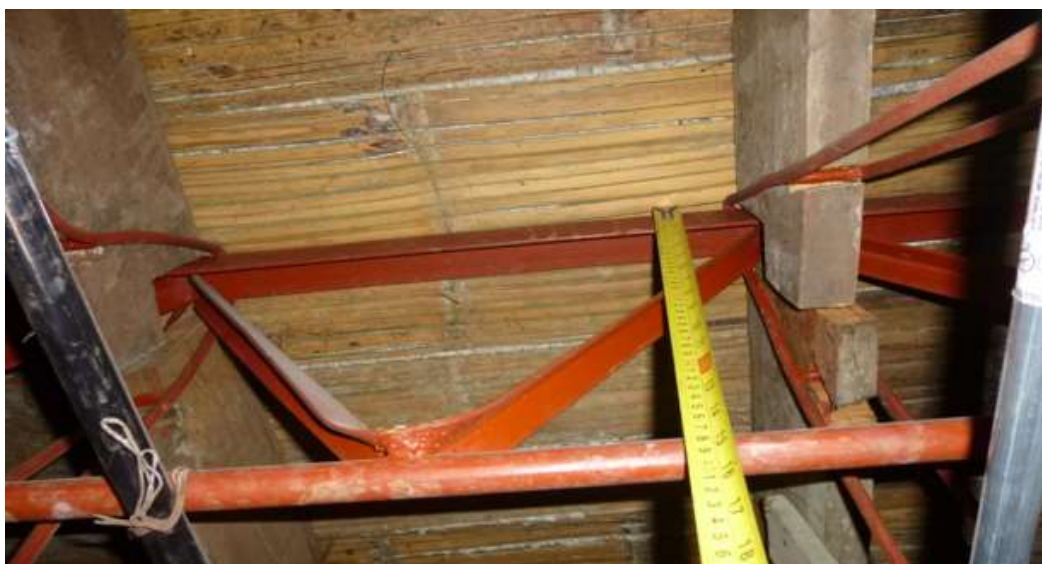
Imagen 61. Detalle de cubierta Fuente: Autor
