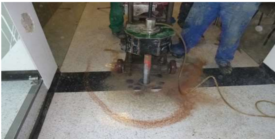
Imagen 52. Extracción de Núcleo de Concreto NC-2 Fuente: Autor
