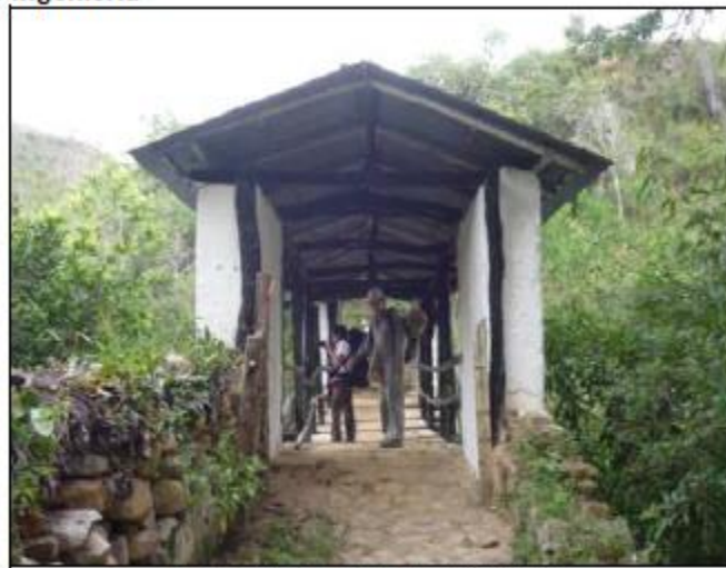
Imagen No. 24. Puente Los Chucureños FUENTE: Registro fotográfico equipo consultor
