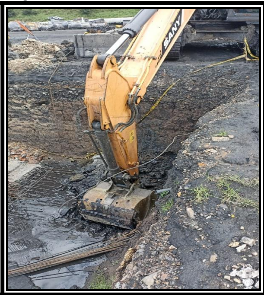
Figura 29. Excavación de Línea de riel
