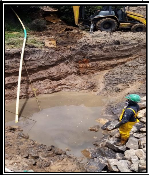
Figura 25. Excavación del Sistema Séptico
