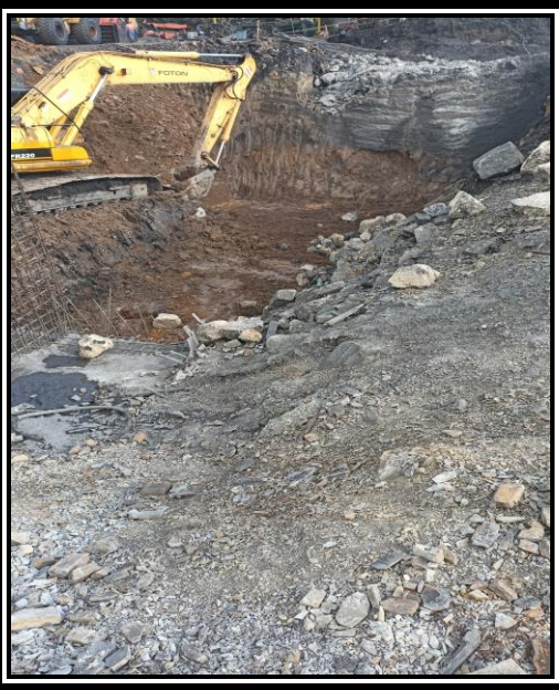
Figura 37. Obra en inicio de Pasantía
