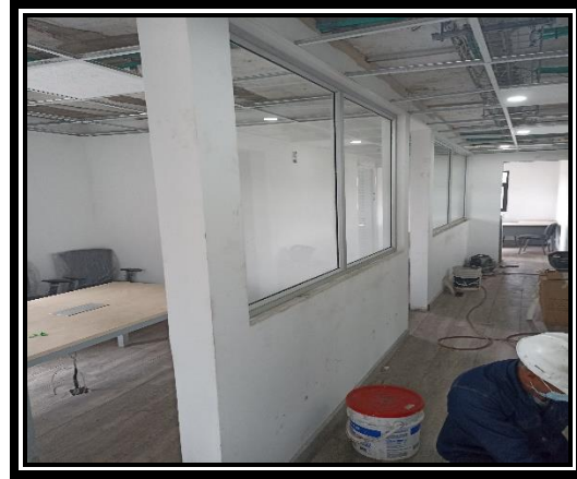
Figura 22. Instalación de Pañete interno 1 piso
