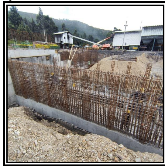
Figura 5. Amarre de aceros Batería 1A-1B
