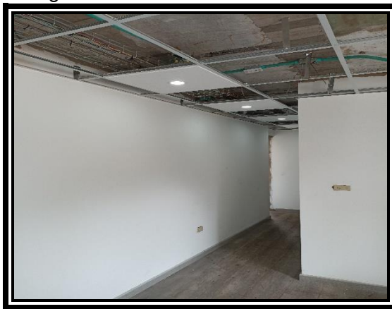
Figura 20. Instalación de Luminarias
