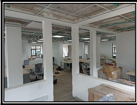
Figura 21. Instalación de Pañete interno 2 piso
