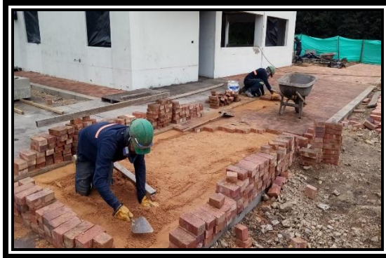
Figura 24. Instalación de Adoquín Fachada Frontal
