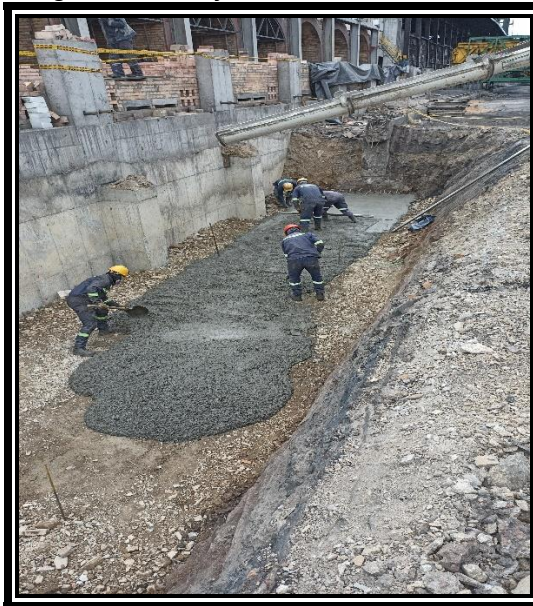
Figura 30. Mejoramiento Línea de riel
