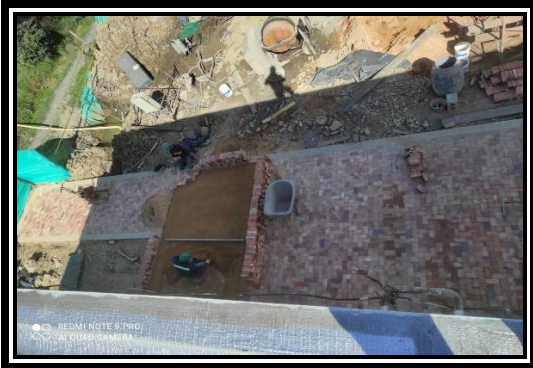
Figura 23. Instalación de Adoquín Fachada lateral
