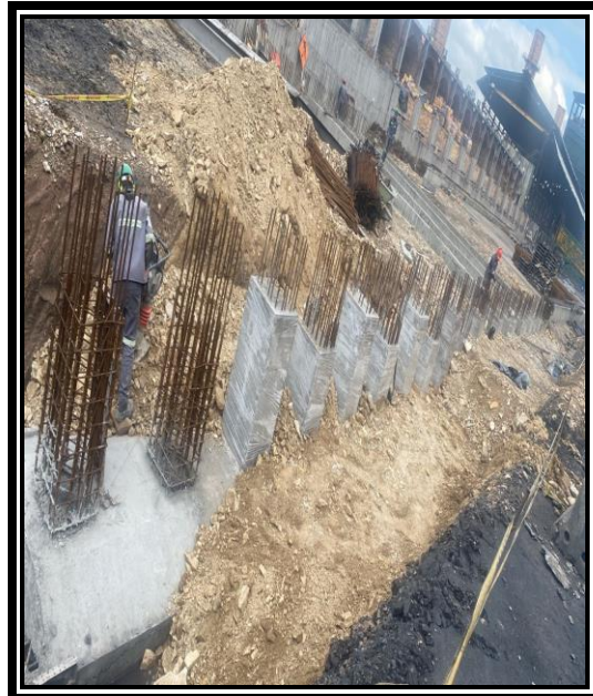
Figura 38. Obra en finalización de Pasantía
