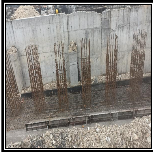
Figura 32. Amarre de aceros(Pedestales) Línea de riel
