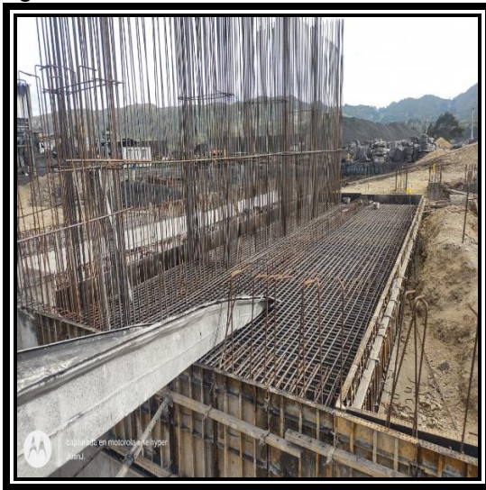
Figura 4. Amarre de aceros Batería 1A-1B
