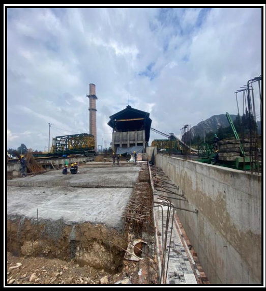
Figura 35. Obra en Inicio de Pasantía
