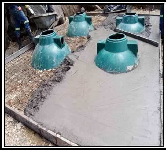
Figura 28. ensamble de sistema séptico
