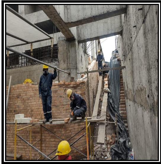
Figura 8. Instalación de mampostería del WHT
