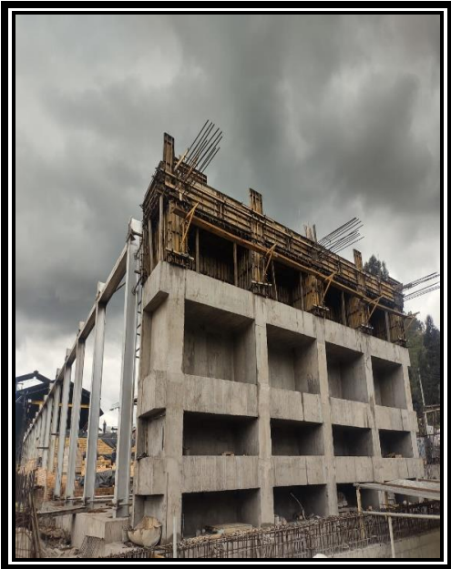
Figura 6. Fundida de Muro de contención Batería 1A
