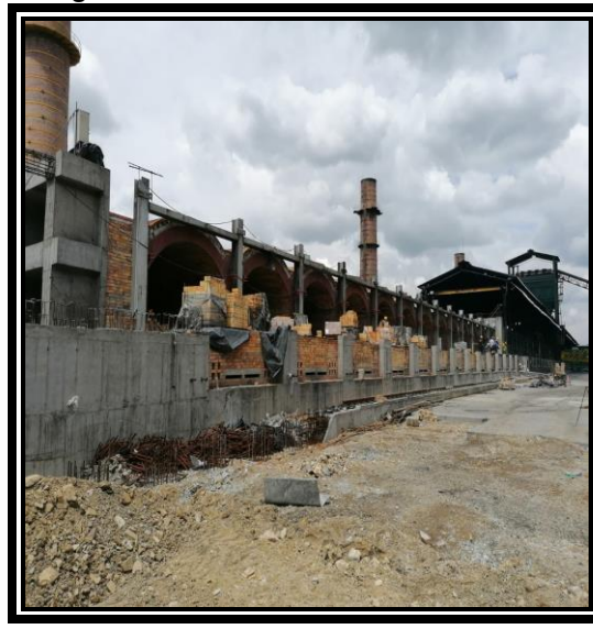
Figura 36. Obra al finalizar Pasantía
