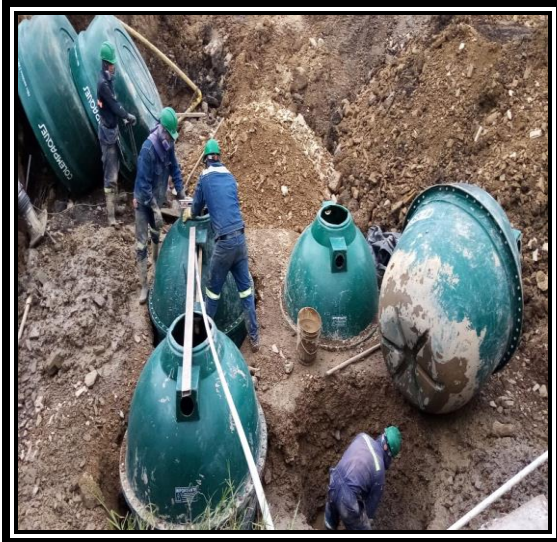
Figura 39. Obra al inicio de Pasantía
