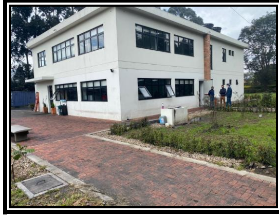
Figura 34. Obra en finalización de Pasantía
