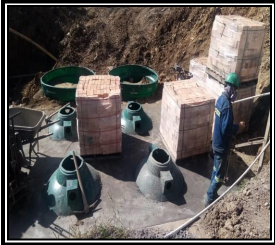
Figura 27. Instalación de mampostería en sistema séptico
