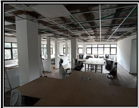
Figura 19. Instalación de Red Eléctrica
