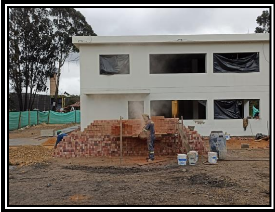
Figura 33. Obra en inicio de Pasantía
