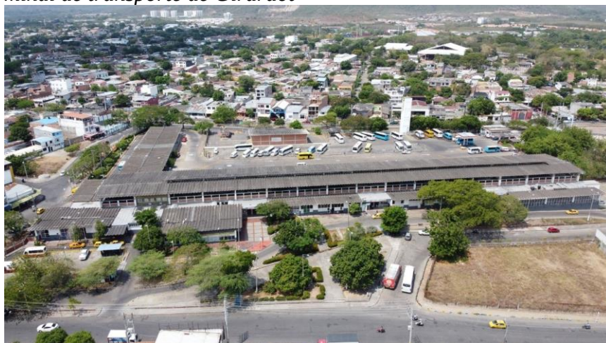
Figura 31. Terminal de transporte de Girardot
