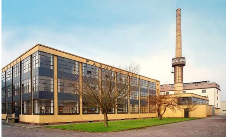
Figura 2. Edificio principal de la Fagus-Werk
