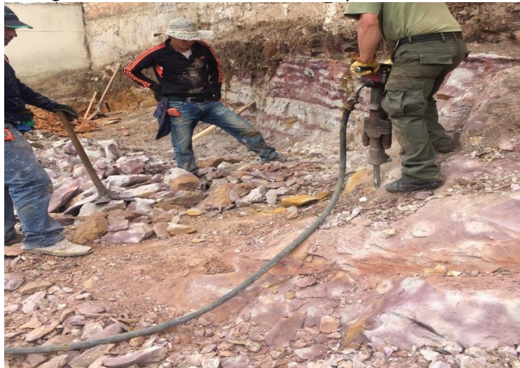
Fotografía 6. Excavación con compresor de martillo.
