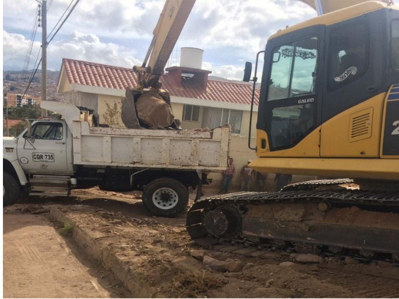
Fotografía 4. Excavación con oruga.
