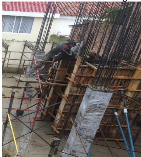
Fotografía 12. Vaciado muro hormigón armado
