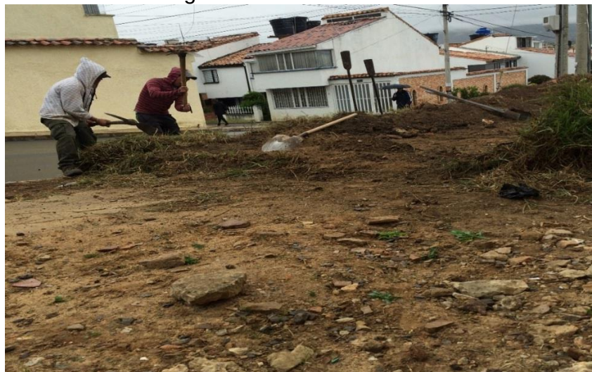
Fotografía 1. Nivelación manual.
