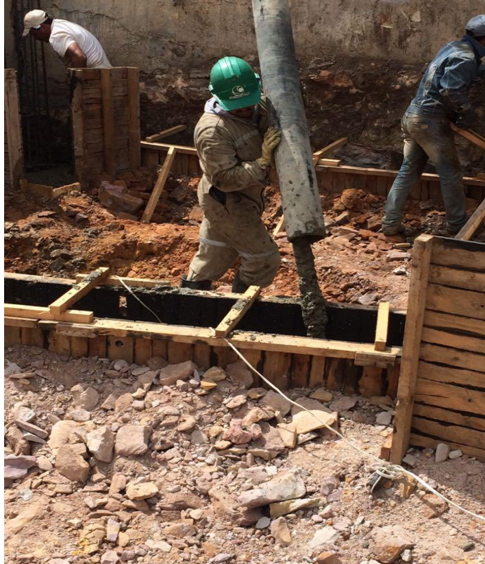
Fotografía 9. Vaciado concreto viga zapatas.
