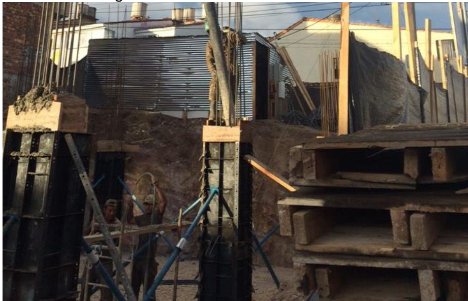
Fotografía 10. Vaciado concreto columnas.
