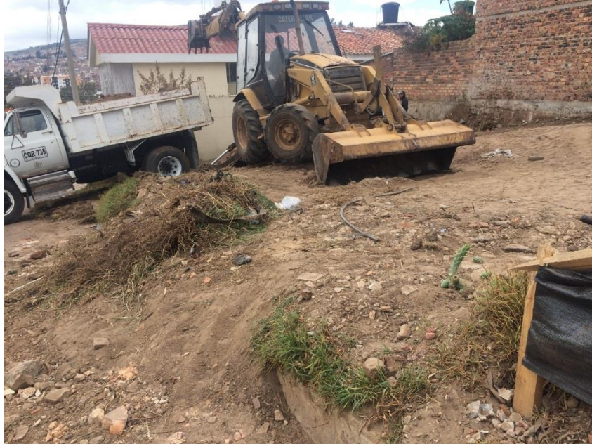
Fotografía 3. Excavación mecánica con pajarita.
