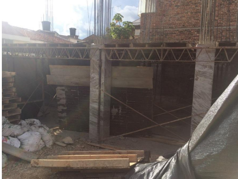
Fotografía 13. Elementos de apoyo placa entrepiso.
