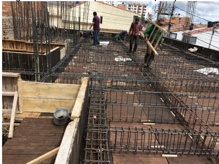
Fotografía 15. Armado placa de entrepiso primer nivel.
