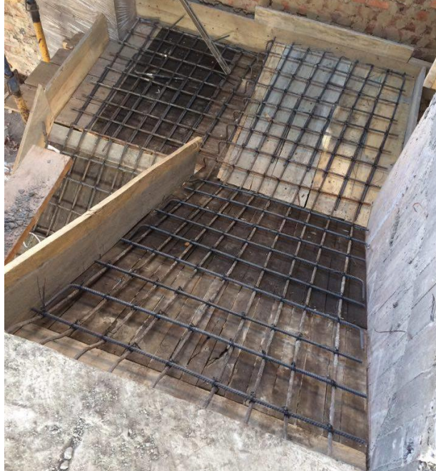
Fotografía 14. Armado escalera sótano.
