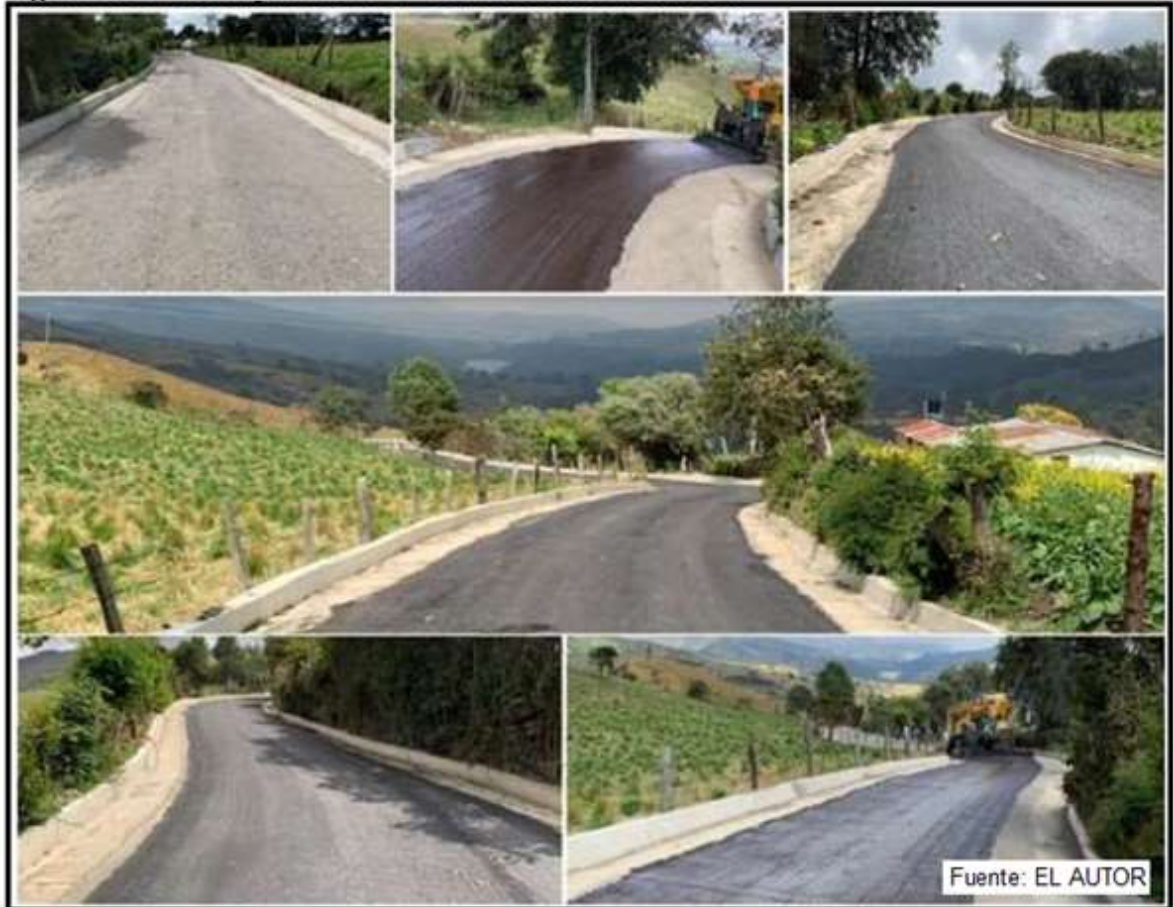
Figura 62. Pavimento de RAP con lechada asfáltica.
