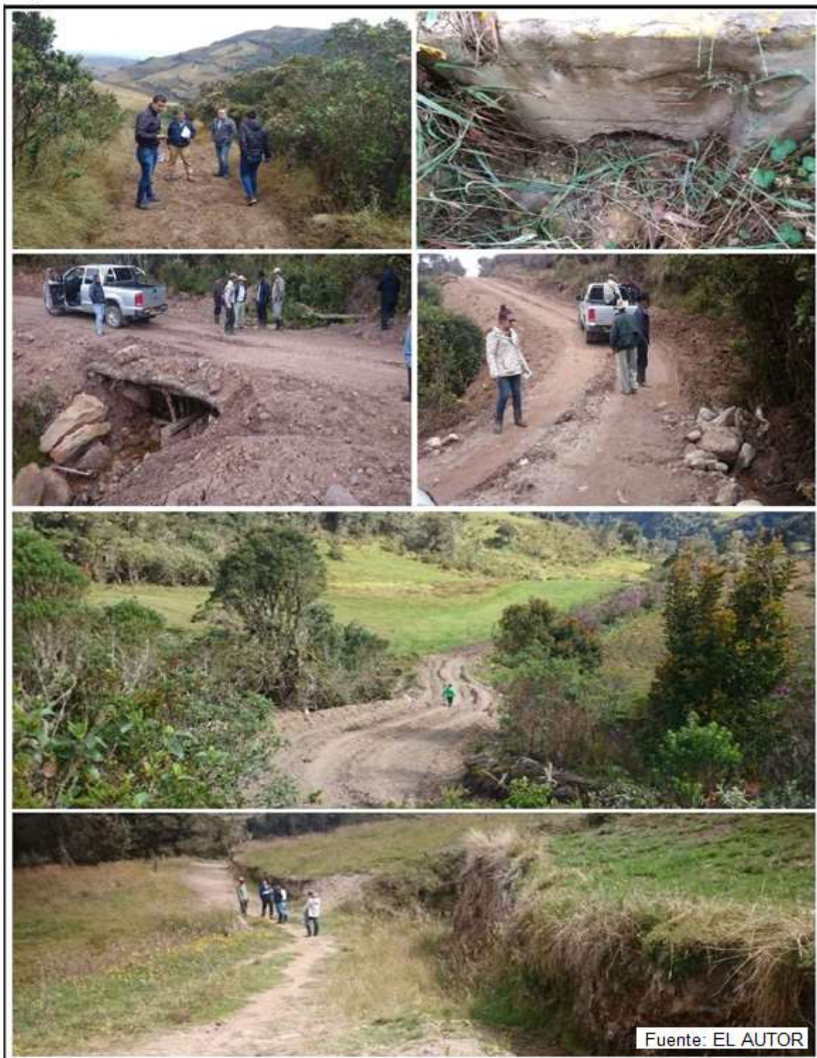
Figura 15. Condición inicial de las vías.
