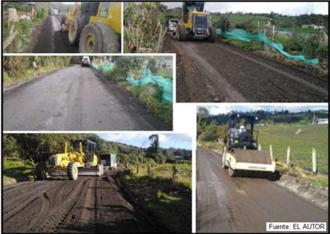
Figura 60. Extendido, conformación y compactación.
