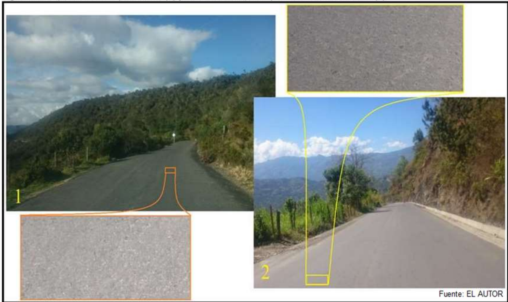
Figura 38. Aspecto final del pavimento (1) y su contraste con un pavimento convencional (2).
