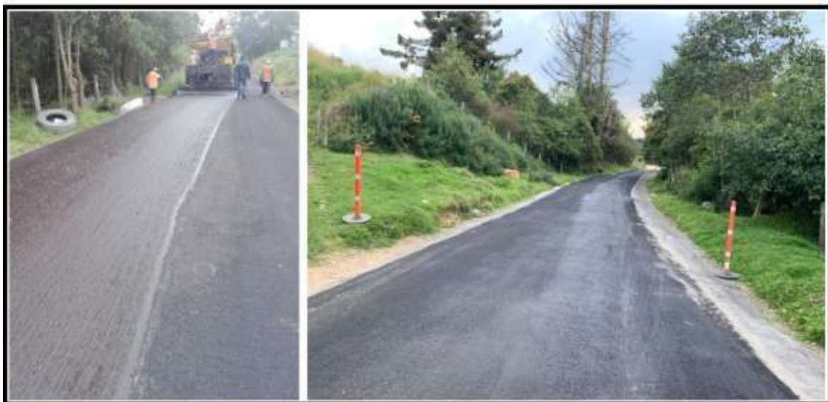
Material estabilizado de RAP con un recubrimiento de micro-pavimento o Slurry Seal. Contrato de obra de la Localidad de Usme.
