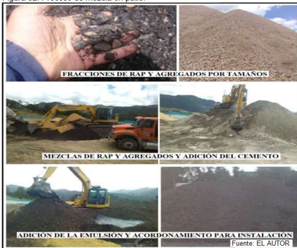
Figura 32. Proceso de mezcla en patio.
