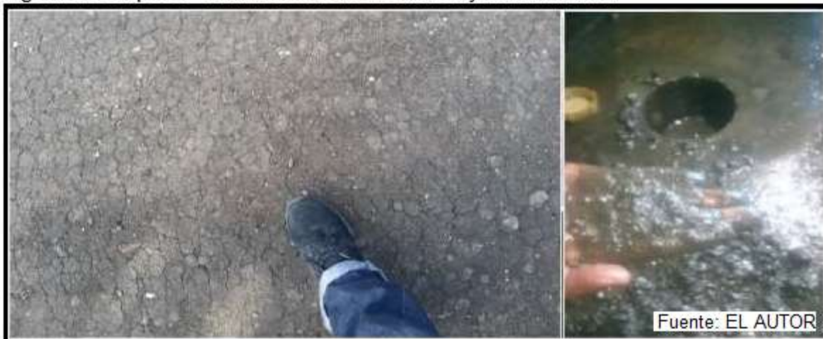
Figura 22. Aspecto de la mezcla en el exterior y en el interior.
