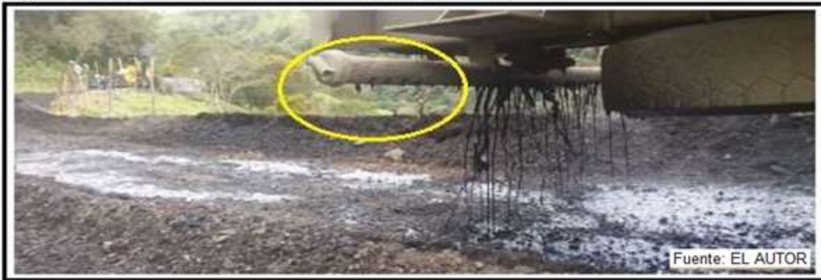
Figura 18. Colocación del material estabilizante del RAP.
