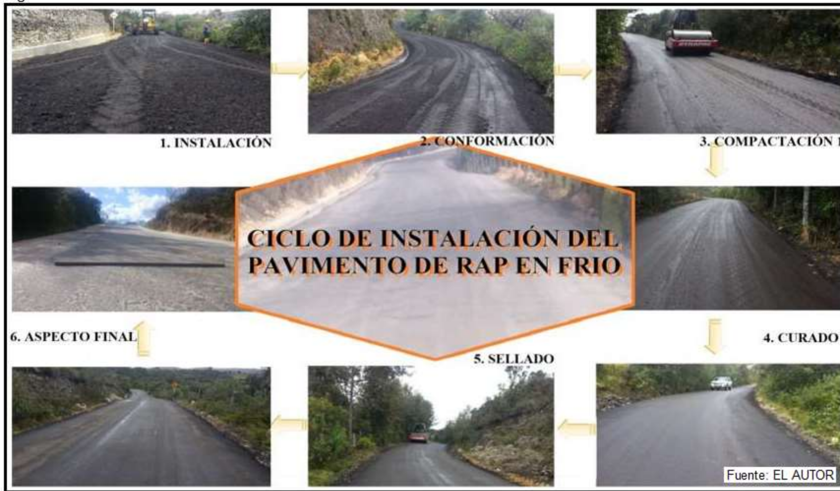
Figura 36. Instalación de la mezcla.
