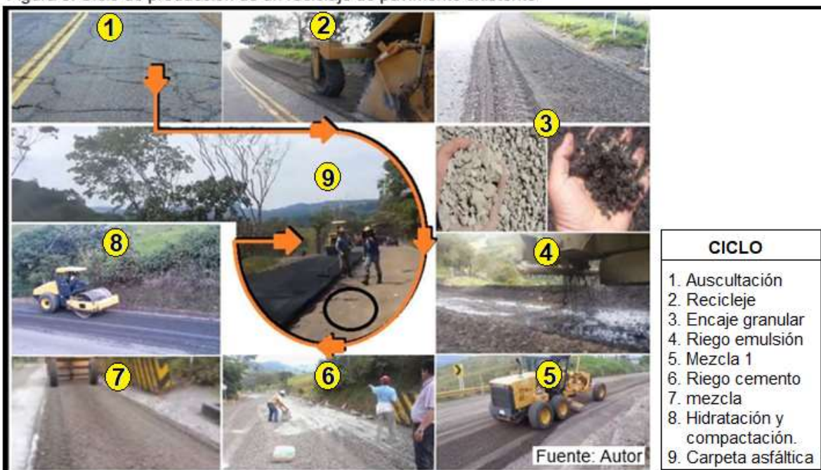
Figura 8. Ciclo de producción de un reciclaje de pavimento existente
