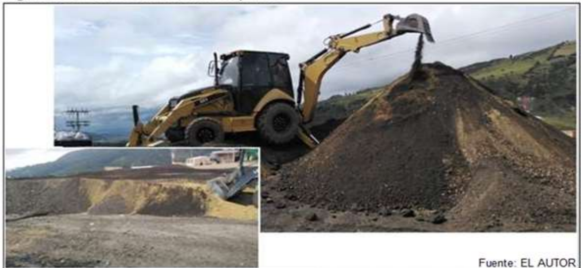
Figura 58. Proceso de mezcla en patio.
