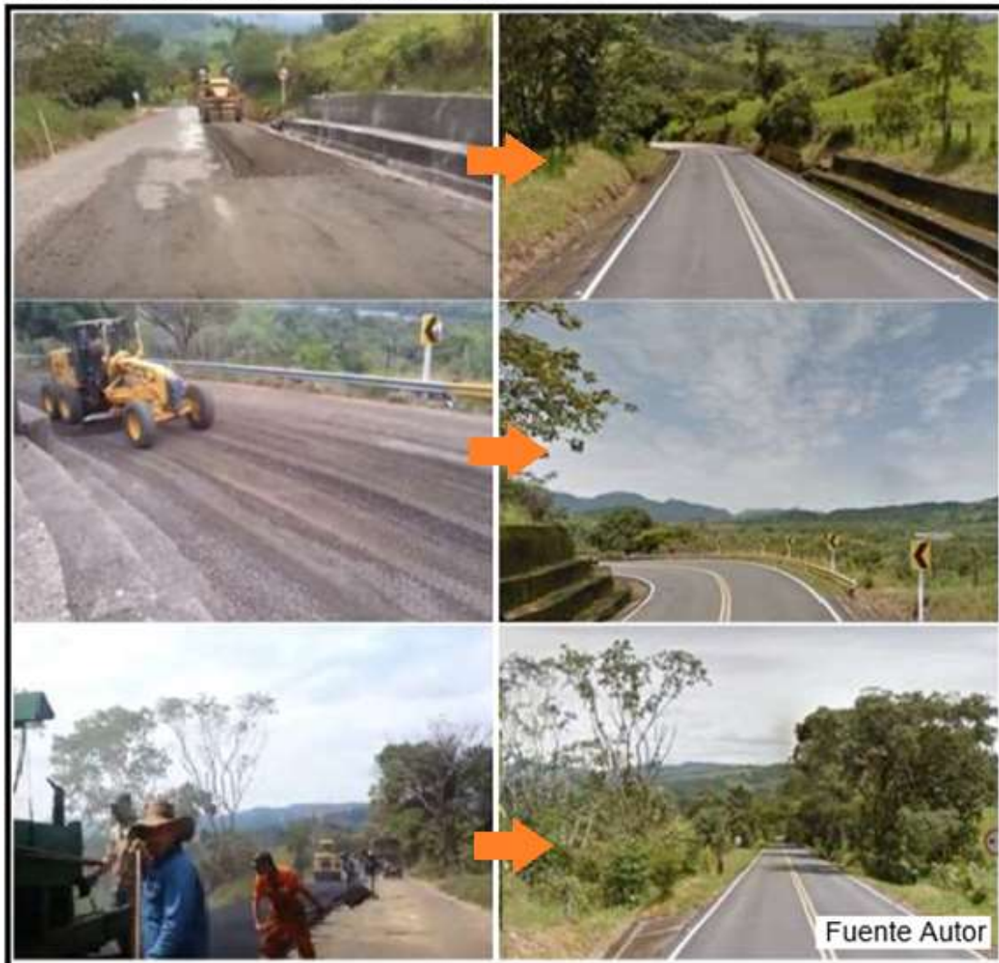
Mantenimiento Carretera Aguas Claras - el Secreto, Regional Casanare - INVIAS. 2012 Construcción de base estabilizada en frío y aspecto del acabado final luego del pavimento
