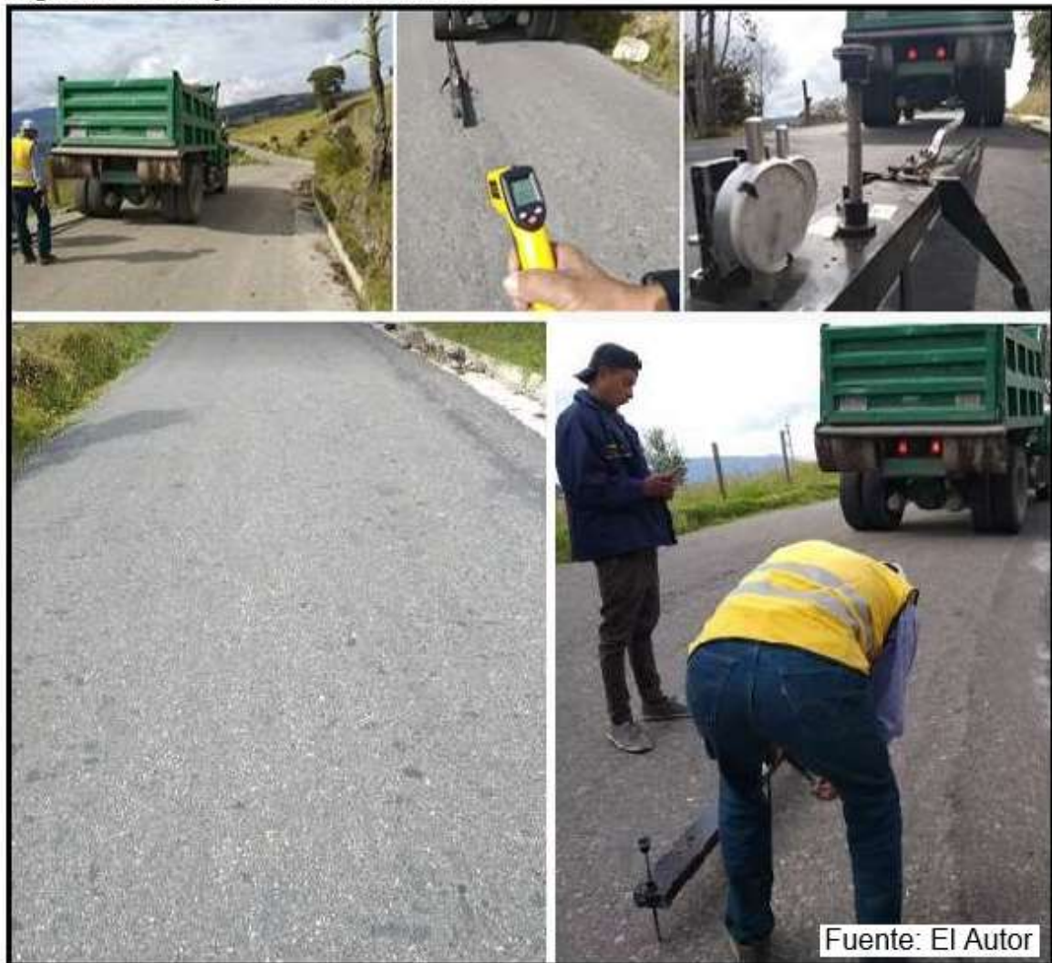
Figura 44. Ensayos de deflectometría
