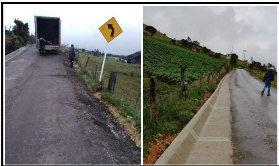
Aspecto vías rurales construidas con RAP, con cuneta lateral.
