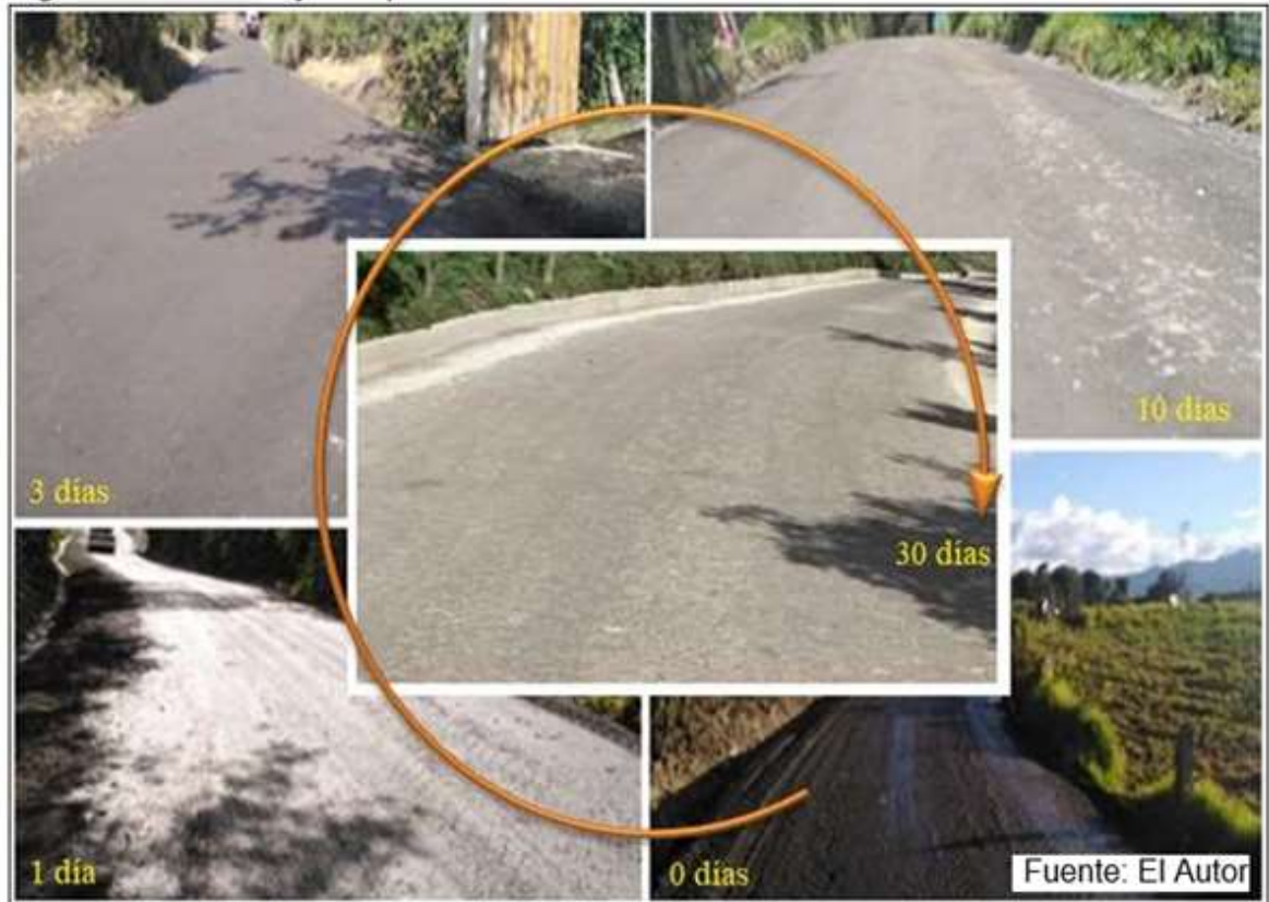
Figura 61. Curado y compactación.
