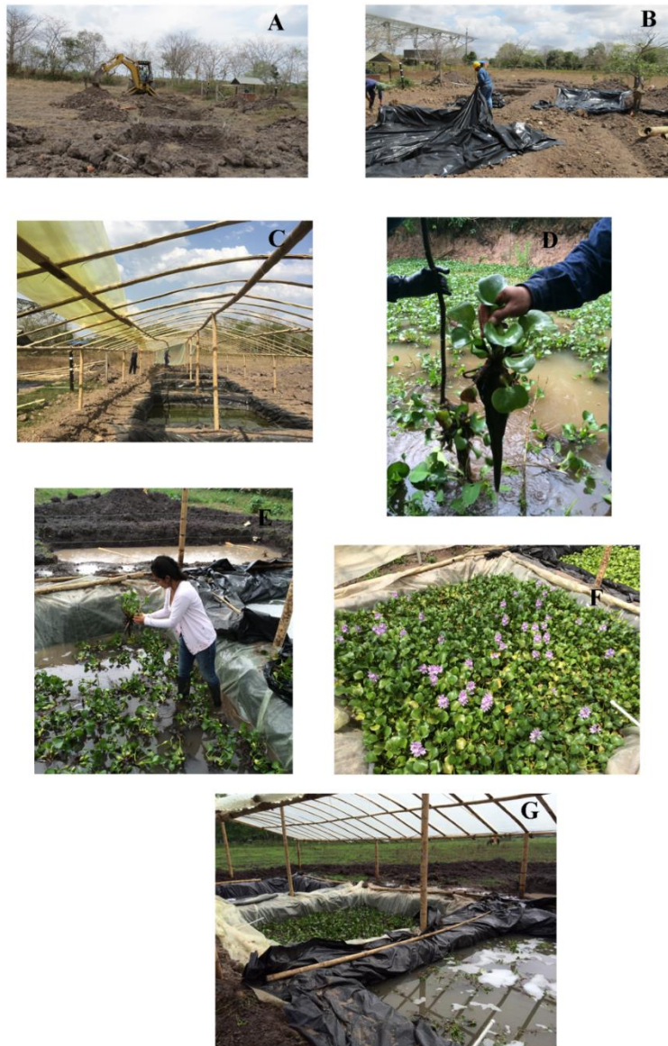
Figura 5. A, B, y C. Adecuación de sistemas de humedales artificiales. D) Recolección de las especies vegetales acuáticas. E. Distribución de las especies vegetales en los humedales. F y G. Especies acuáticas al finalizar el fitotratamiento.
