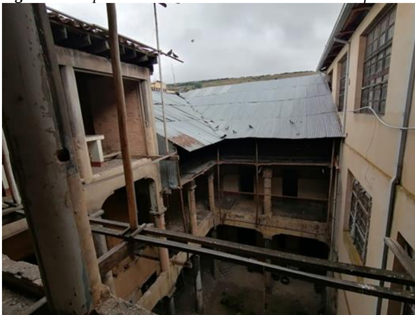
Figura 10. Inspección visual interior del estado de la edificación
