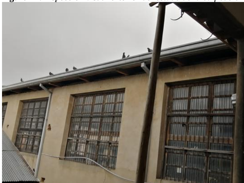
Figura 11. Inspección visual exterior del estado de la edificación
