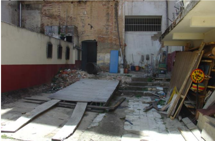
Figura 7. Inspección visual inicial planta baja – levantamiento
