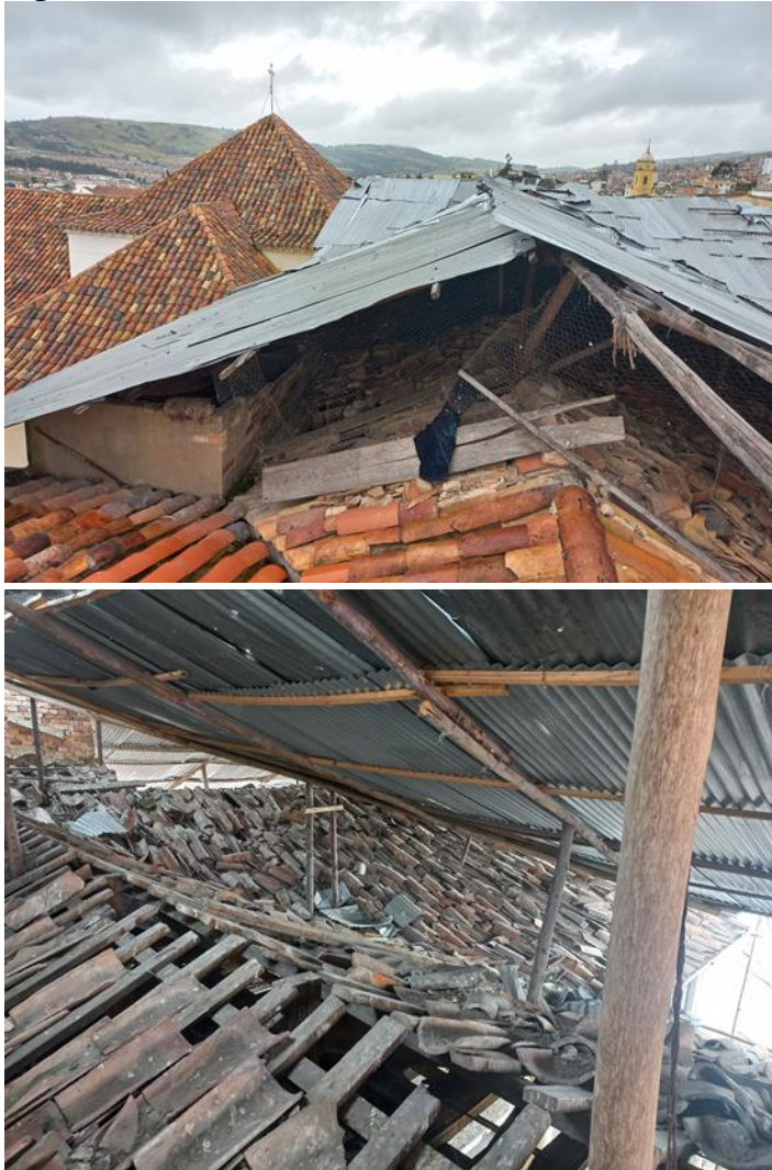
Figura 12. Estado actual de cubierta
