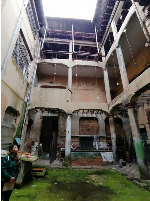
Figura 13. Estado actual interior
