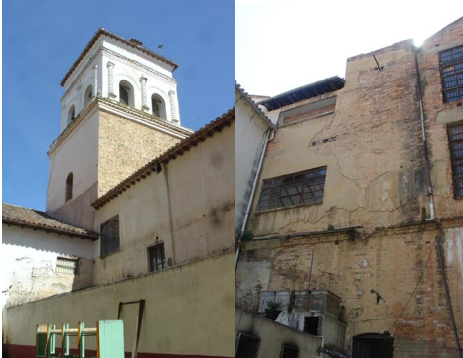
Figura 9. Inspección visual fachada externa
