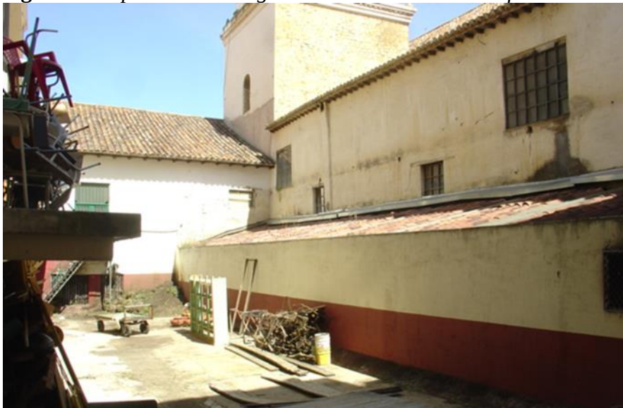
Figura 8. Inspección visual general del estado de la edificación exterior
