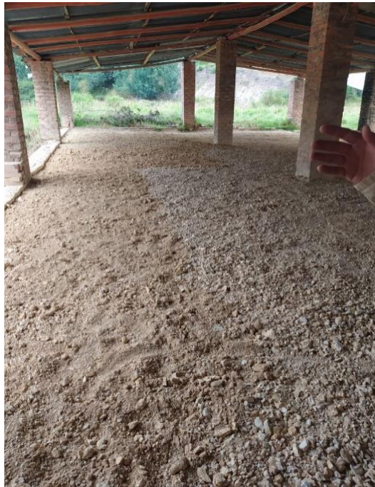
Figura 6: Secado de material Fuente: propia
