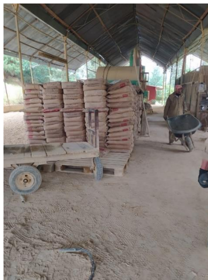
Figura 12: Empacado y almacenamiento del material Fuente: propia.
