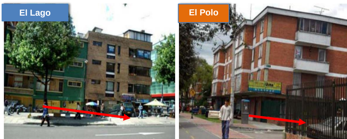
Figura 4. Problemas de Asentamientos en Edificaciones bogotanas Fuente: El Tiempo, modificado autor
