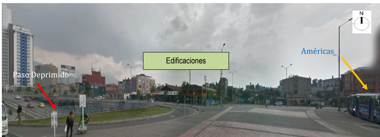
Figura 16. Vista General Costado Occidental paso deprimido Av. Américas con Calle 26 Fuente: Google Maps, modificado autor.
