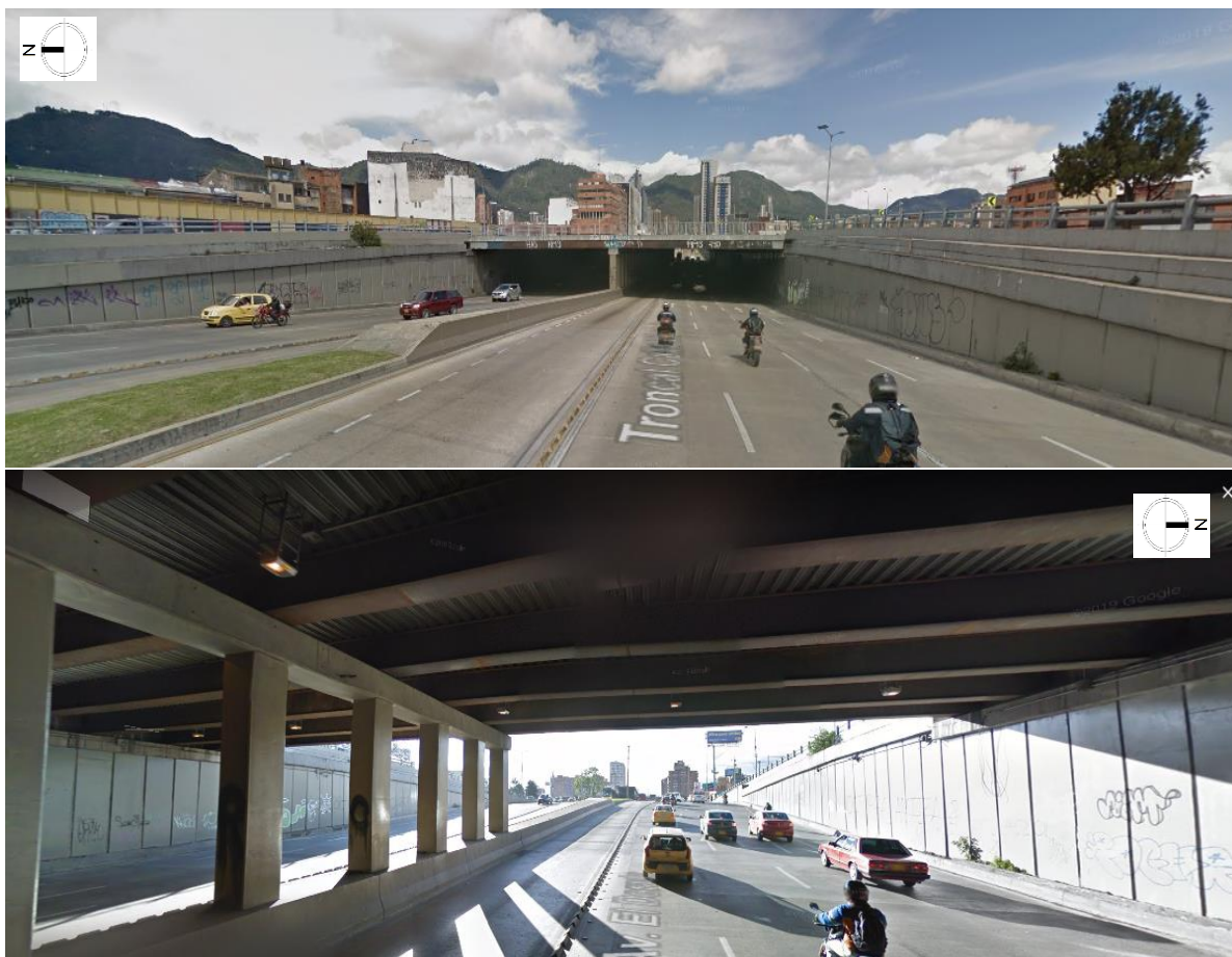
Figura 18. Vista general interna- paso deprimido Américas Calle 26 Fuente: Google Maps, modificado autor.
