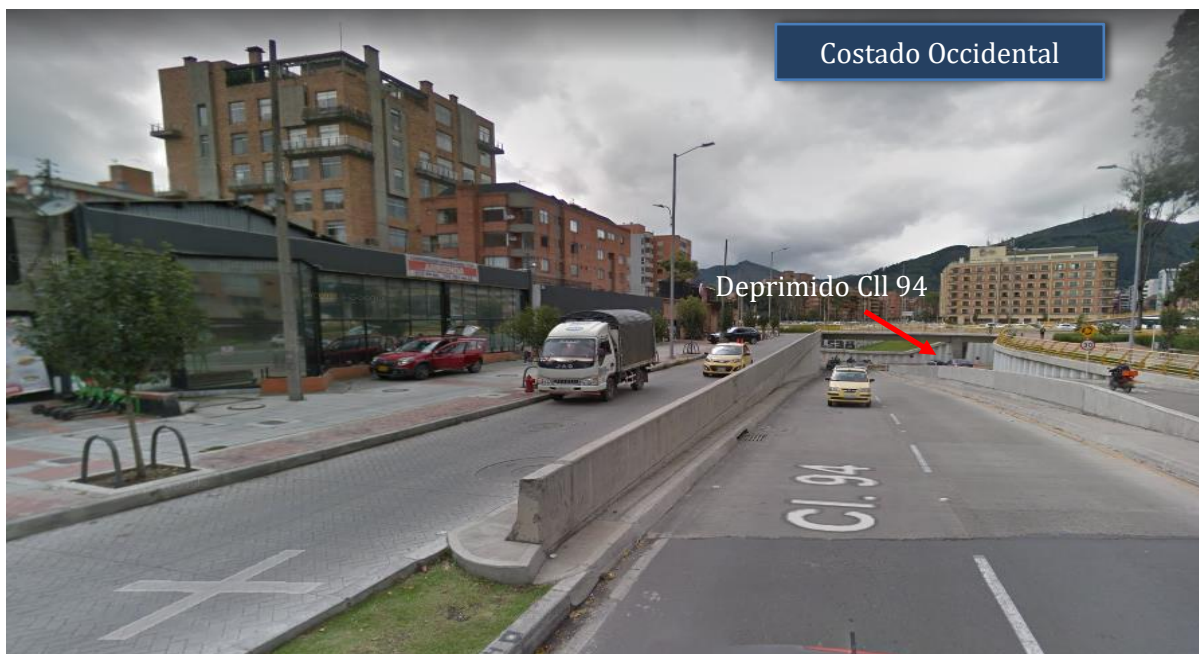
Figura 38. Vista general costado Occidental – Deprimido Calle 94 con Carrera 30
