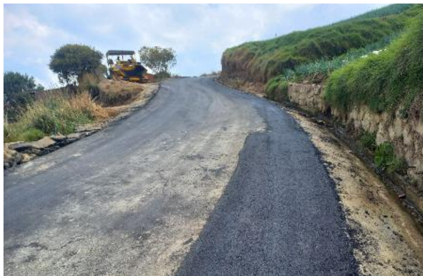
Figura 7 Reparcho con asfalto
