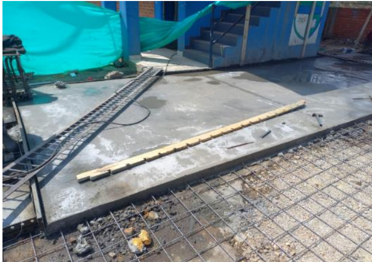
Figura 10. . Instalación placa con malla electro soldada
