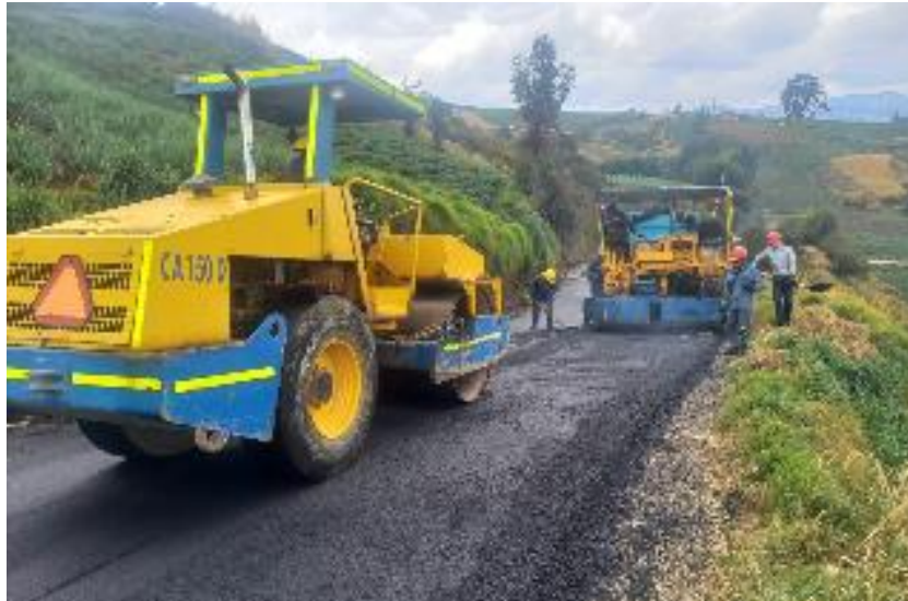
Figura 2. Instalación pavimento flexible.
