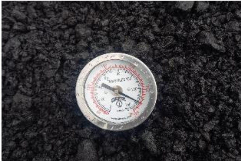
Figura 3. Toma temperatura mezcla asfáltica
