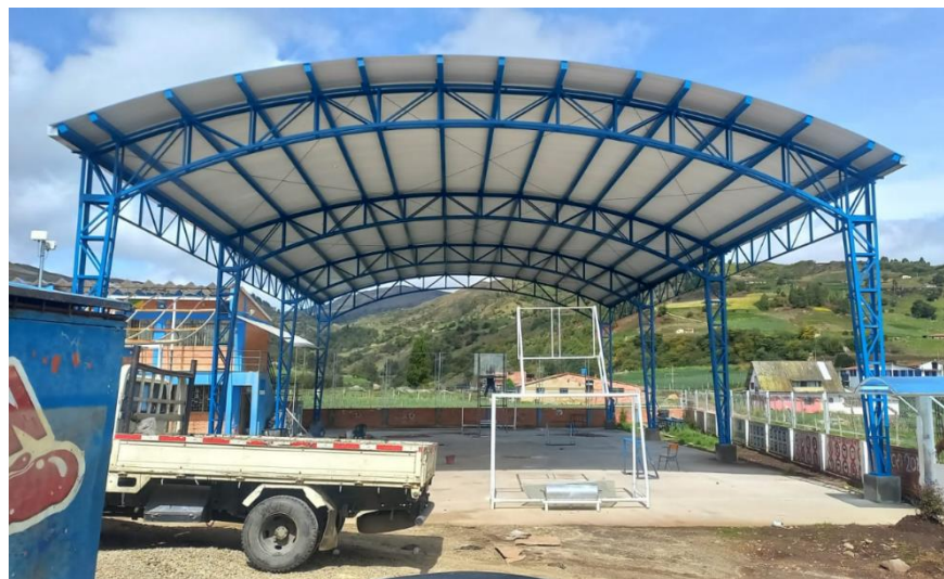
Figura 12. Cubierta Vrd Suse
