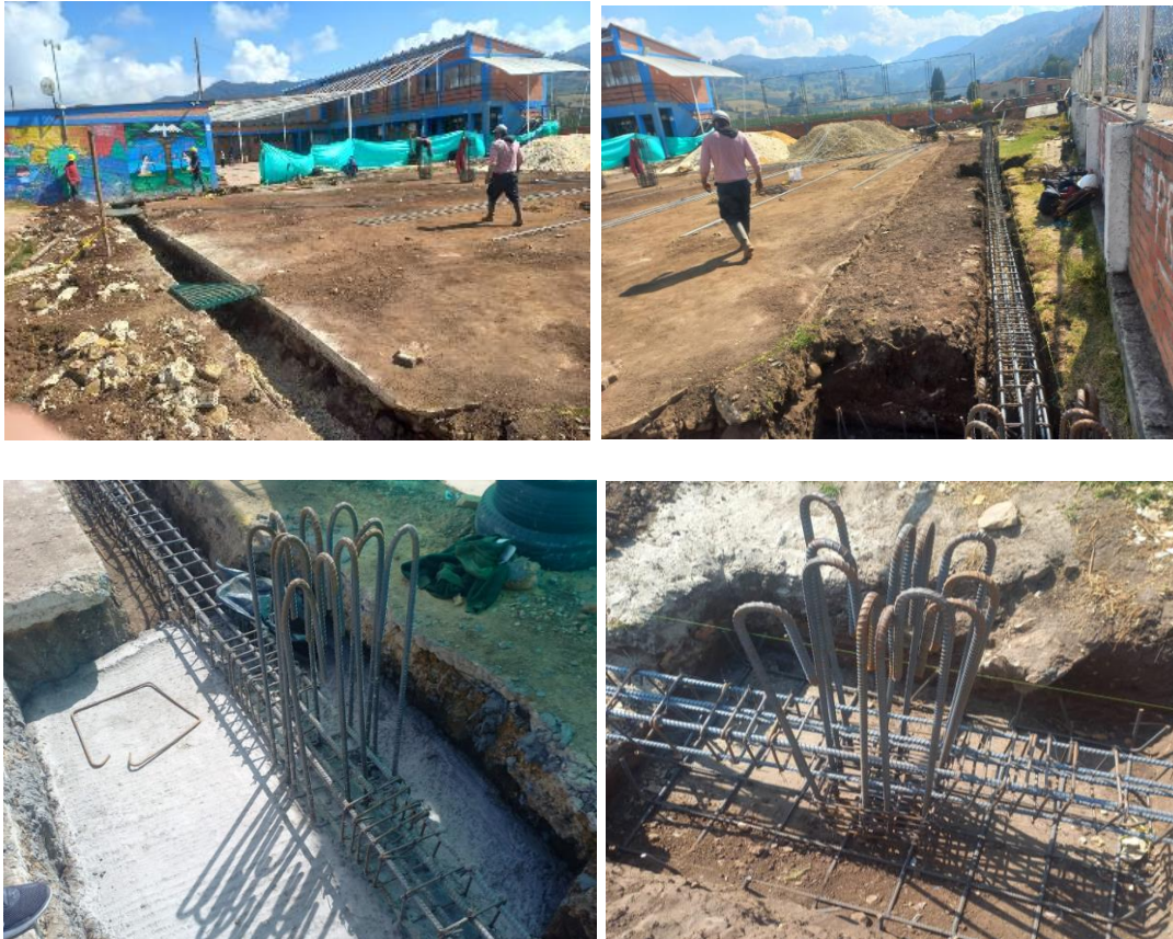
Figura 8 Proceso constructivo cimentación
