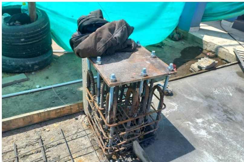
Figura 9. Acero de pedestal.
