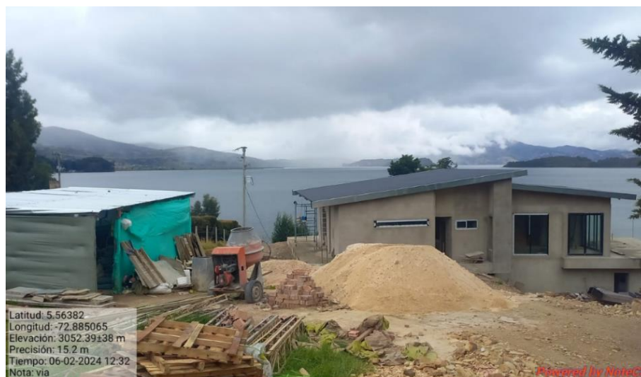
Figura 15. Construcción en Ronda de protección lago de Tota
