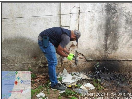
Realización de regata en columna C3.
