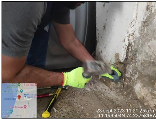
Realización de regata en columna C2.
