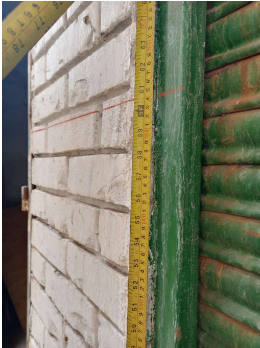
Fotografía 4, Casas, A., & Hernández, C. (2023). Detalle de verificación de nivel del edificio y asentamientos [Fotografía digital].
