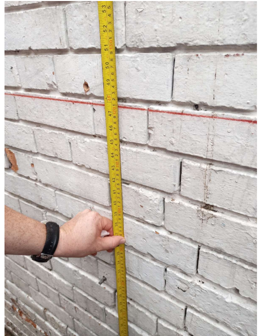
Fotografía 5, Casas, A., & Hernández, C. (2023). Detalle de verificación de nivel del edificio y asentamientos. [Fotografía digital].
