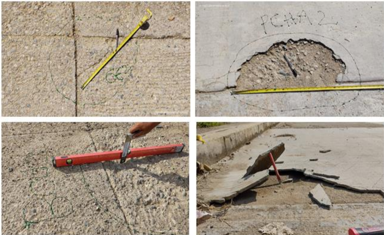
Figura 6. Puntos inspeccionados y valorados 1.
