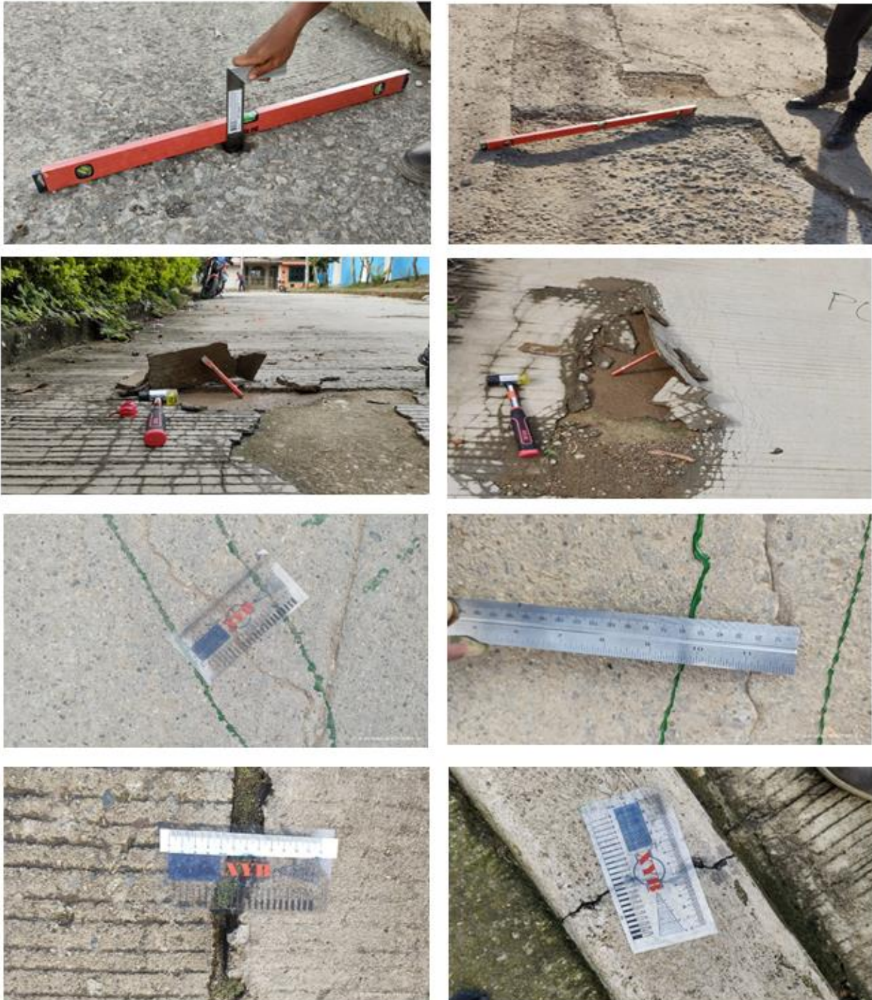
Figura 7. Puntos inspeccionados y valorados 2.
