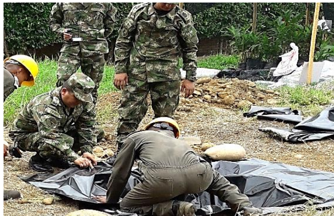
Figura 6. Recubrimiento de los humedales artificiales.
