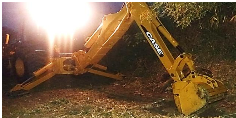
Figura 3. Excavación de los humedales.
