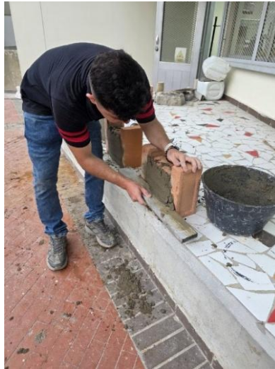
Figura 45 Construcción de los Muretes de la muestra de control 0%
