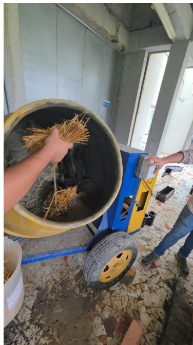
Figura 51 Adición de fibra a mezcla de 0.5%
