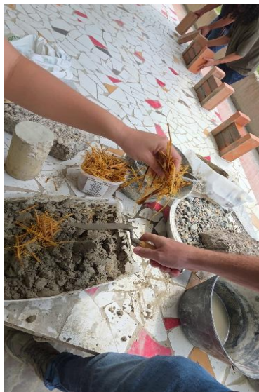
Figura 48 Preparación de la mezcla de mortero con adición de fibra al 1 %
