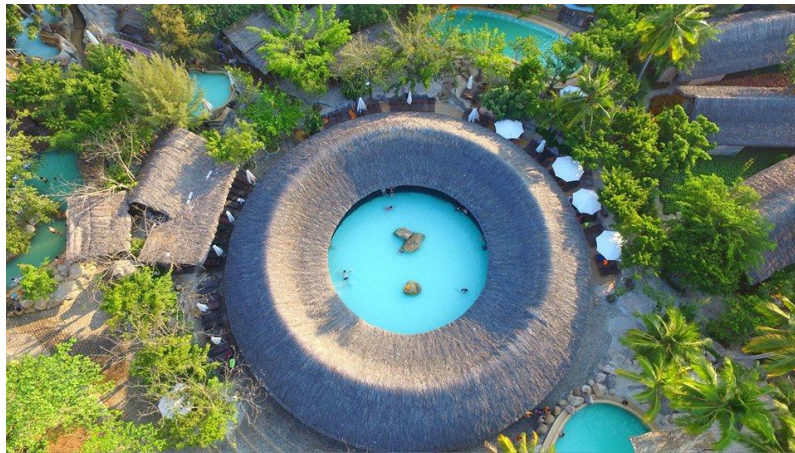
Figura 8: Vista Aérea I resort
