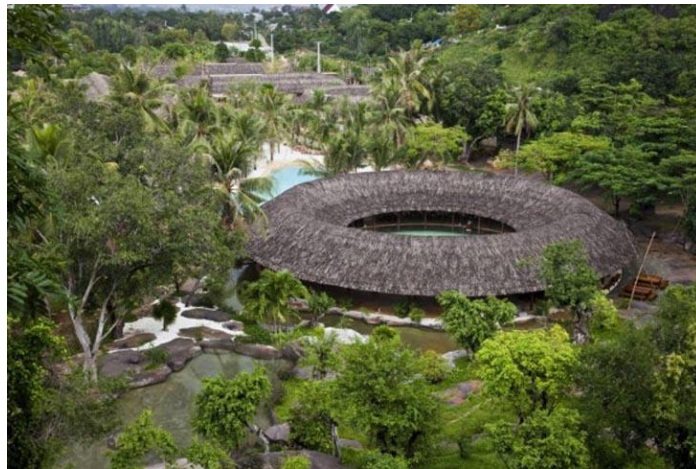
Figura 7 Vista Interna I resort
