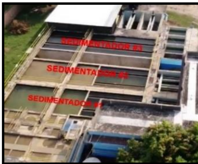
Imagen 16. Proceso de Sedimentación.
