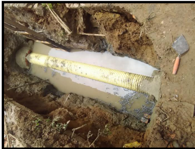
Imagen 50. Acople de tubería de concreto - PVC Novafort con ladrillos tolete.
