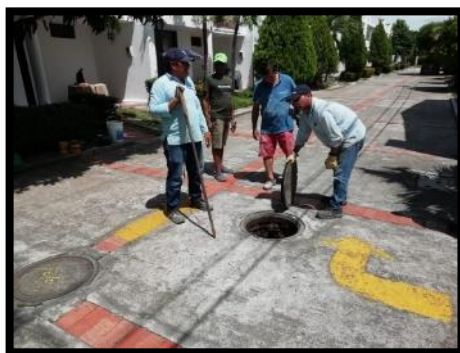
Imagen 31. Visita técnica conjunto Santa Mónica II.
