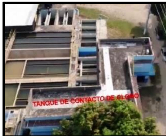
Imagen 18. Proceso de cloración.
