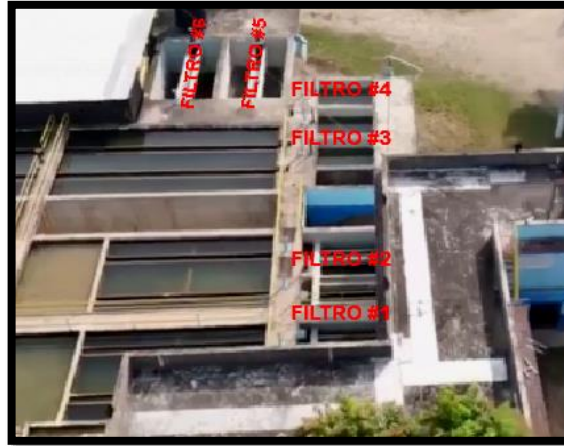
Imagen 17. Proceso de Filtración.
