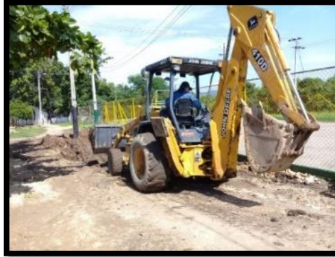
Imagen 52. Compactación con tránsito de retroexcavadora tras culminar intervención.
