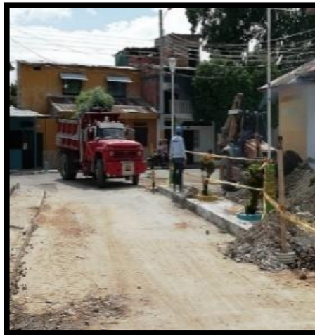
Imagen 48. Limpieza y culminación de intervención tramo T3235.
