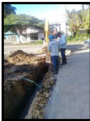
Imagen 53. Excavación en el tramo T1338.
