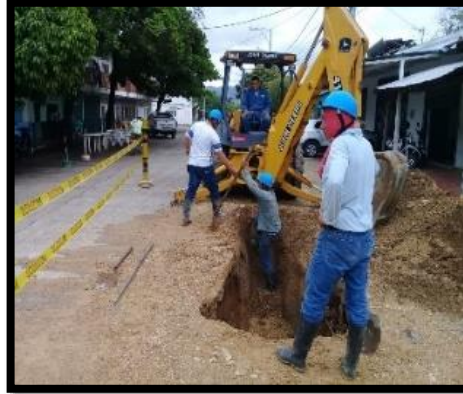
Imagen 49: Instalación de tubería de alcantarillado Novafort de 10 pulgadas.
