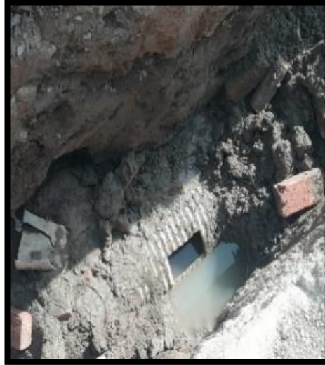
Imagen 44. Rotura de tubo de alcantarillado Novafort 12 pulgadas para instalar acometida domiciliaria.
