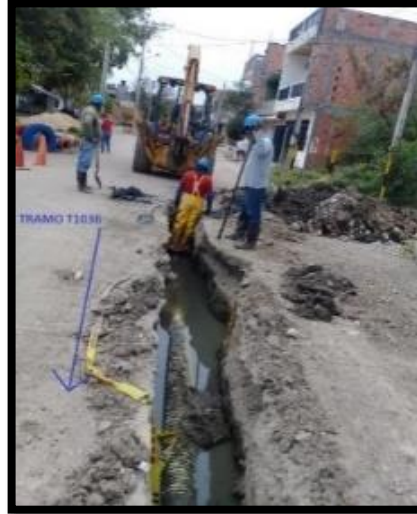
Imagen 38. Instalación de tubería Novafort 12 pulgadas tramo T1036.
