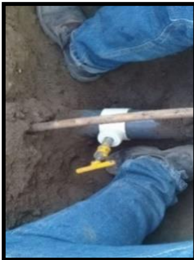
Imagen 28. Instalación de collar de derivación 6X2 pulgadas.
