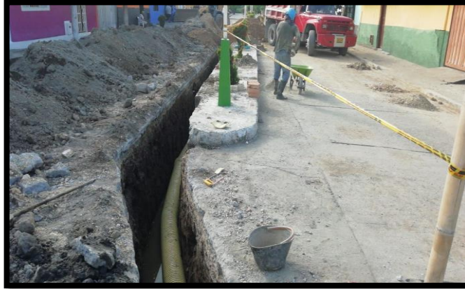
Imagen 47. Giro de tubería tramo T3235.
