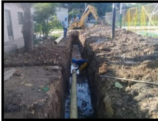
Imagen 51. Instalación de tubería de alcantarillado Novafort de 10 pulgadas.
