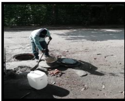
Imagen 36. Instalación de tapa vibrocompactada, Urbanización Aragón III.
