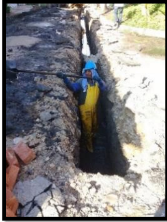
Imagen 54. Instalación de tubería PVC Novafort de 12 pulgadas desde el pozo inicial.
