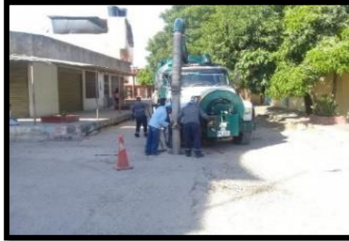
Imagen 60. Sondeo por succión en pozos de inspección.
