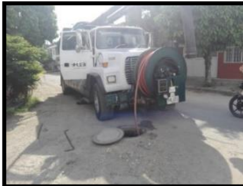
Imagen 61. Sondeos por presión por presión en pozos de inspección.
