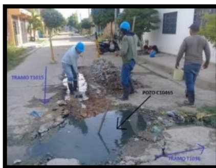
Imagen 37. Taponamiento en pozo C1045.
