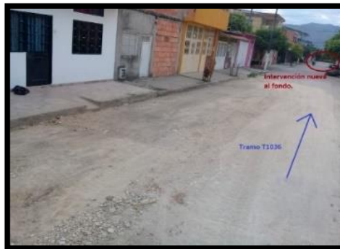
Imagen 40. Intervención culminada y ubicación de tramo nuevo.
