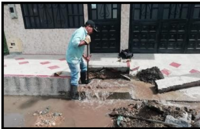
Imagen 26. Reparación de tubería de red domiciliaria, Orden #15093.
