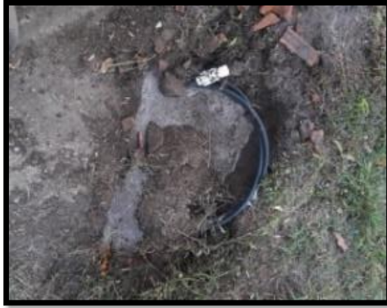
Imagen 29. Conexión domiciliaria instalada de manguera PF de ½ pulgada.
