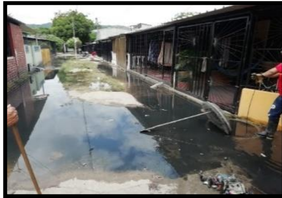
Imagen 57. Sondeo mecánico tras taponamiento por aguas lluvias.
