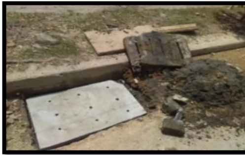
Imagen 34. Instalación de tapa de sumidero de aguas lluvias Aragón.
