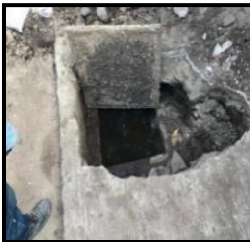
Imagen 33. Caja de inspección de predio en reparación.
