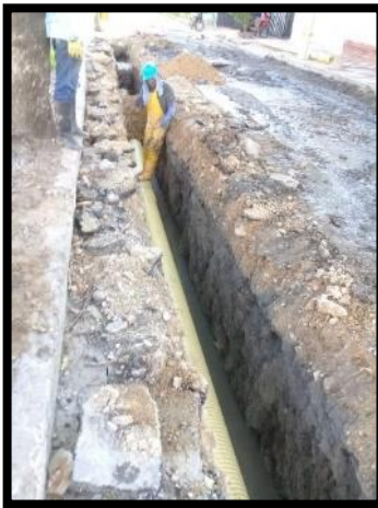
Imagen 55. Instalación de tubería de alcantarillado PVC Novafort de 12 pulgadas a pozo final.
