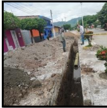
Imagen 46. Instalación de tubería de alcantarillado Novafort de 12 pulgadas.
