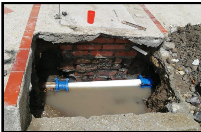
Imagen 27. Tubería de red domiciliaria reparada con uniones universales, Orden #15093.
