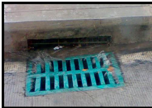
Imagen 35. Diseño recomendado para tapa de sumideros de aguas lluvias.
