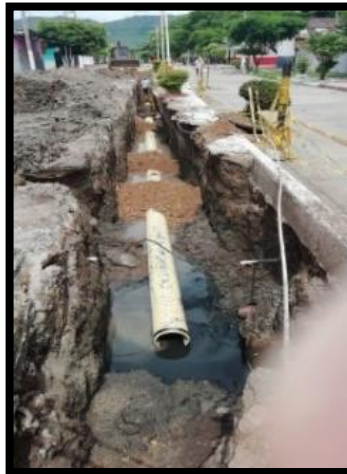
Imagen 45. Instalación de tubería de alcantarillado Novafort de 12 pulgadas.
