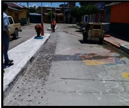
Imagen 43. Rotura de pavimento con martillo mecánico.
