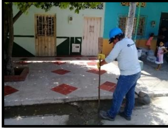
Imagen 25. Reparación de fuga de agua potable cerca al medidor B/San German, Orden #14959.
