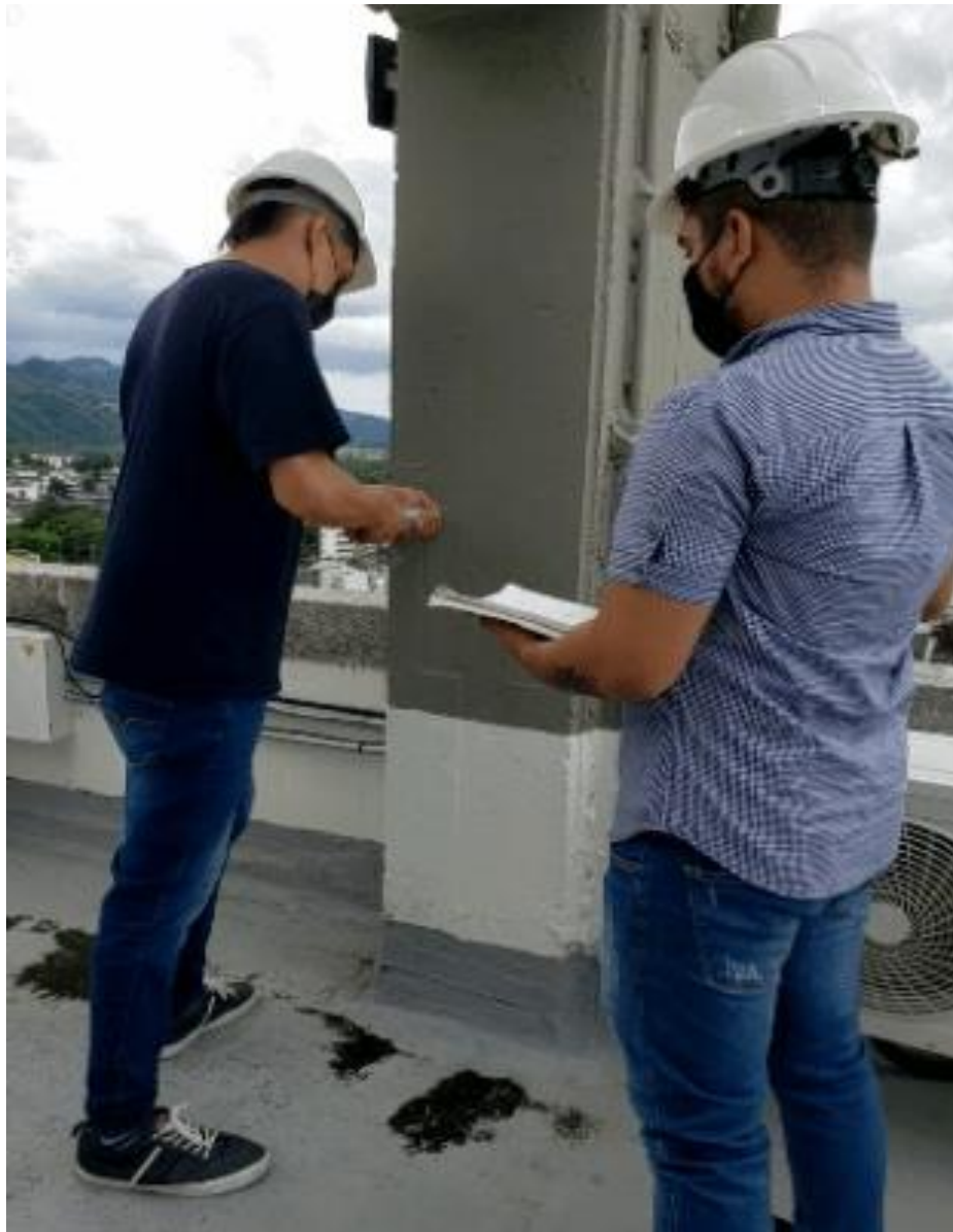
Figura 24 Toma de prueba de esclerometría en la azotea
