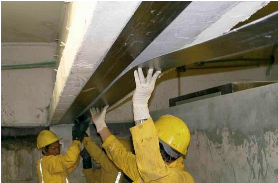
Figura 56 Refuerzo con Laminas
