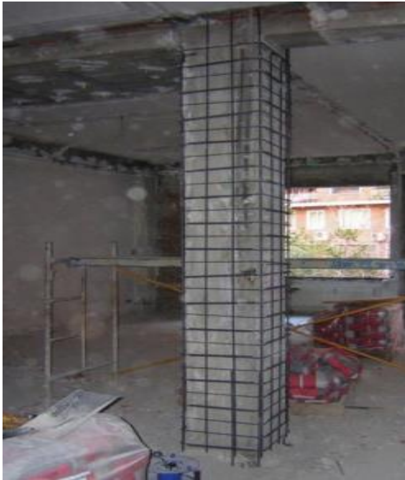
Figura 57 Columna durante proceso de recrecido
