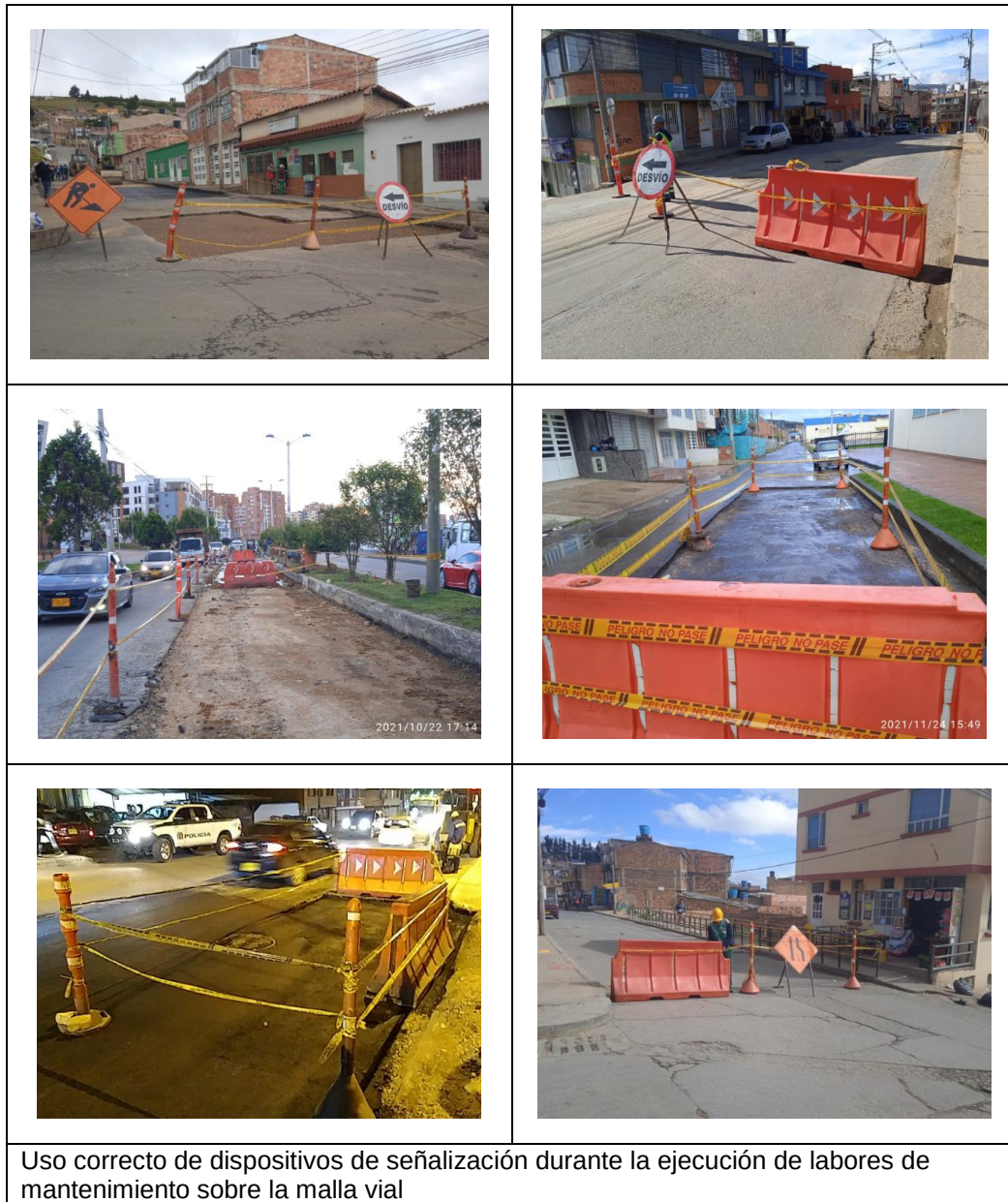
Ilustración 15 Señalización vial implementada en obra
