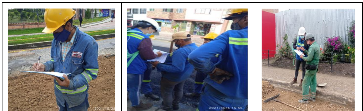
Ilustración 14 Diligenciamiento Censo Personal en Obra
