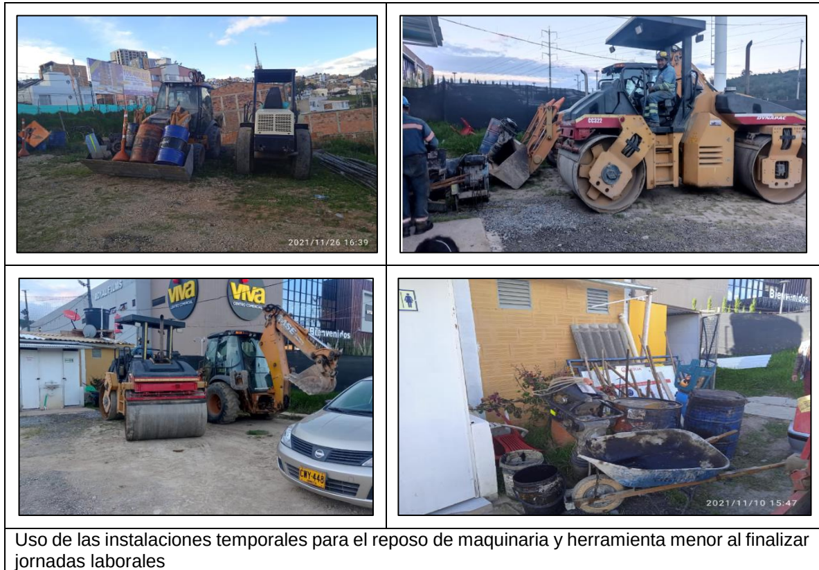
Ilustración 7 Instalaciones Temporales maquinaria, equipos y herramienta menor
