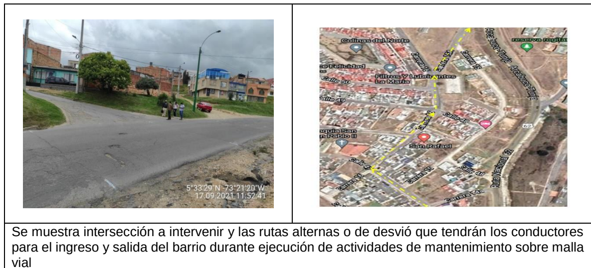
Ilustración 20 Intersección entre Cra 14a y Cll 48 sobre vía nacional y ruta de desvío
