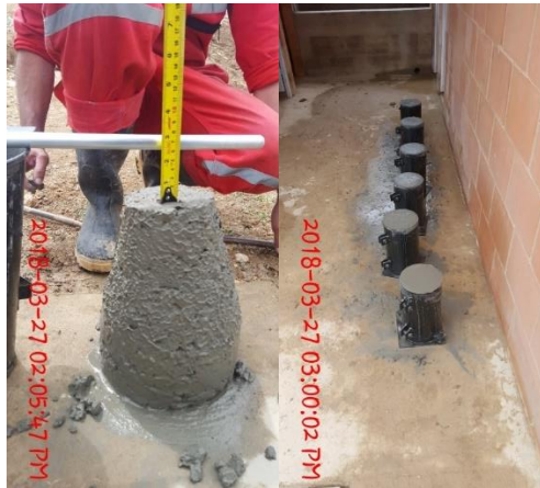
Figura 33. Prueba de asentamiento concreto normal de 3.000 psi, grava de 1/2 (2,5 in) y fabricación y curado de especímenes en obra.
