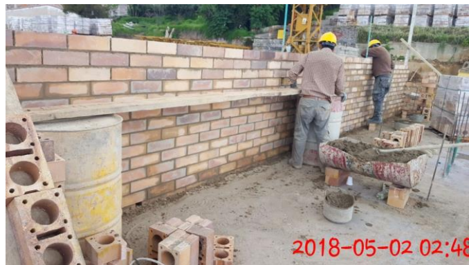
Figura 37. Levantamiento de mampostería estructural
