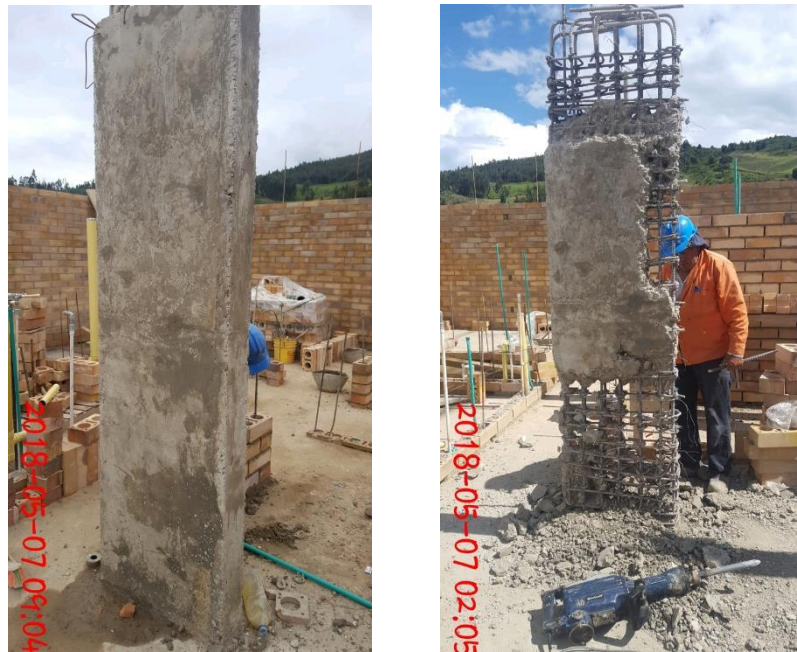
Figura 32. Demolición muros pantalla
