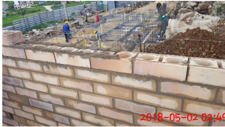
Figura 36. Junta de pega (1 cm) para mampostería estructural
