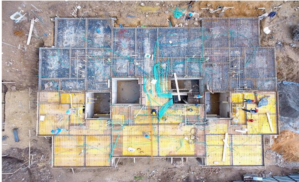
Figura 21. Amarre de acero de placa de entrepiso y contrapiso
