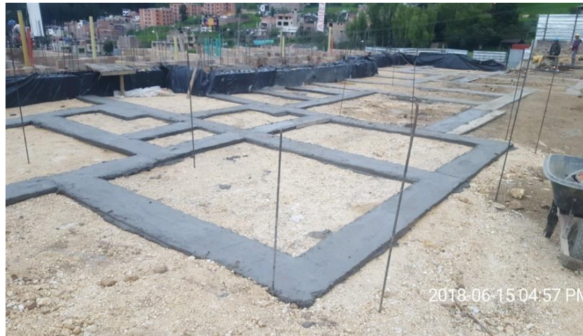
Figura 20. Solado para vigas de cimentación
