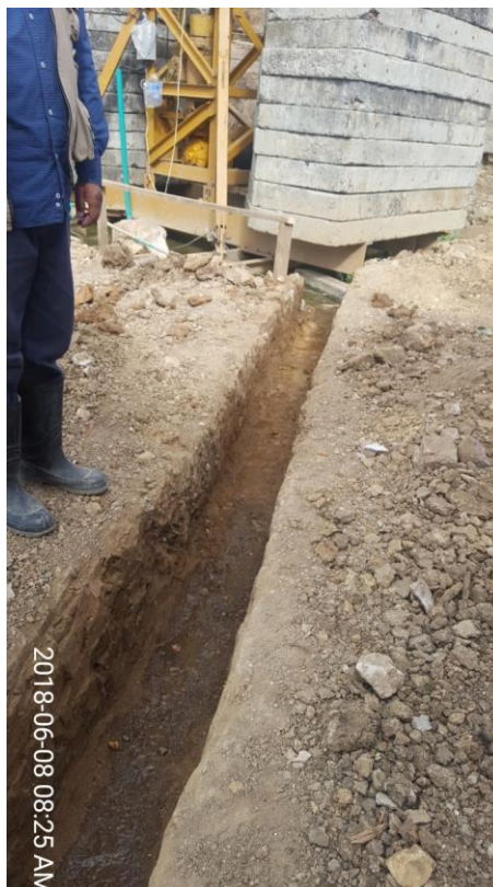
Figura 45. Excavación mecánica para locación de tubo de PVC de 6", reduciendo el empozamiento junto a la torre grúa
