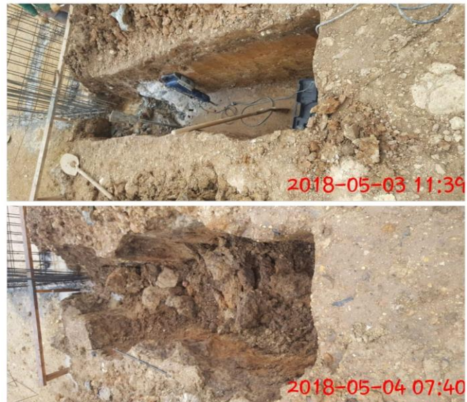
Figura 17. Excavación manual de viga antes y después de deslizamiento
