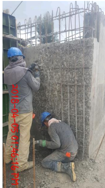
Figura 31. Demolición tramo muro de contención
