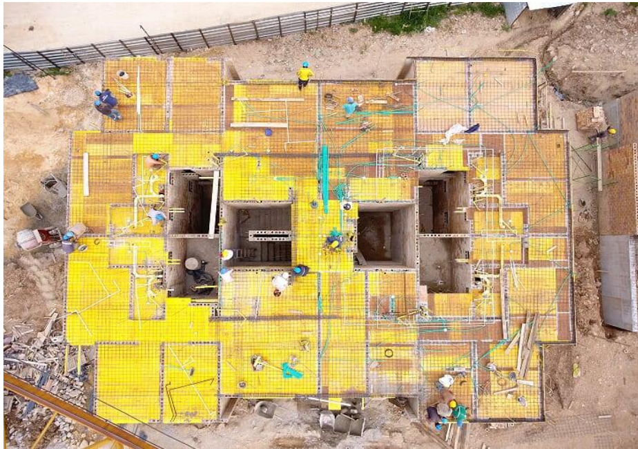
Figura 30. Armado del sistema StenMix placa de entrepiso
