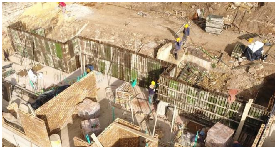
Figura 26. Armado de formaleta metálica para muro de contención
