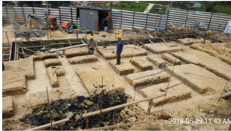
Figura 18. Excavación vigas de cimentación
