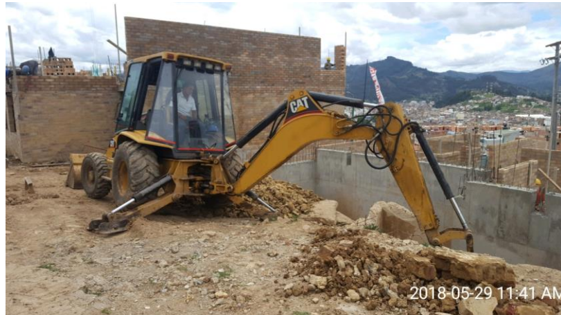
Figura 19. Excavación mecánica de material suelto
