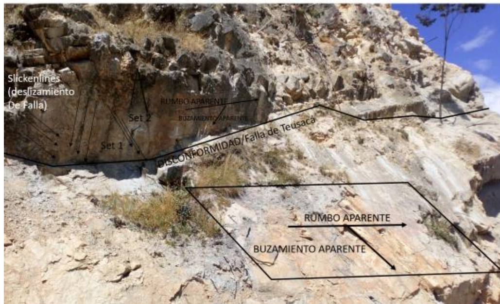
Figura 11. Falla de Teusacá y pares de fracturas Pre y Sintectónicas. Costado oeste viaducto Bogotá-La Calera cerca de Kurnik-Puente y Box Culvert (1009078N, 1008635E, 2815msnm). Fuente: Fotografía Autor de este trabajo.
