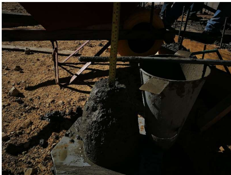
Imagen 2: Medición Del Slump Del Concreto Patrón Fuente: Propia.
