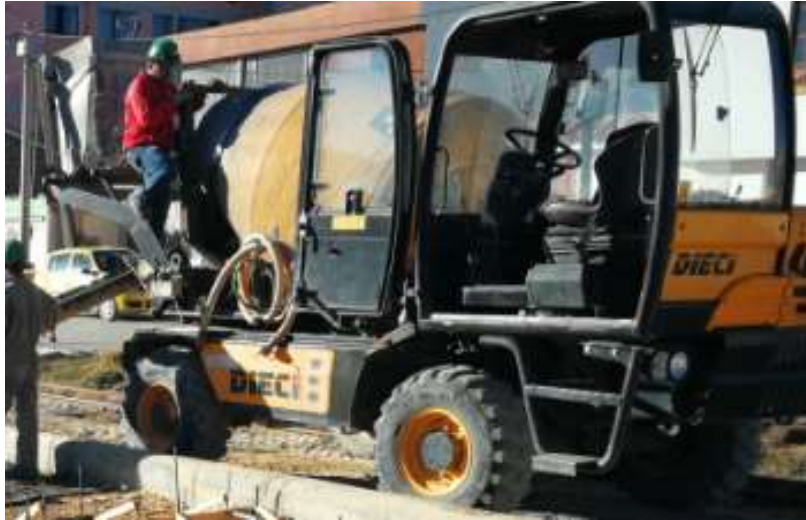
Imagen 1: Elaboración De La Mezcla De Concreto Fuente: Propia.
