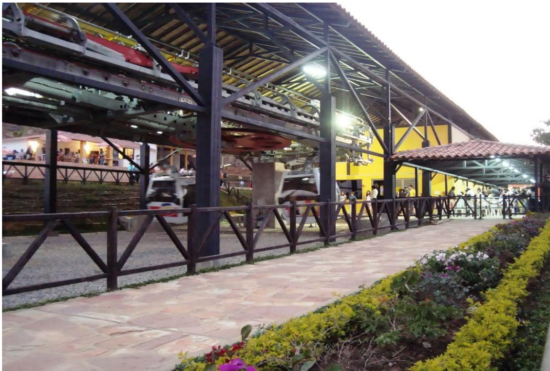
Figura 14. Estación del Teleférico de Panachi en la Mesa de los Santos.
