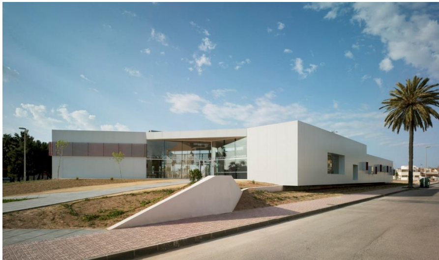
Figura 20. Acceso a la Escuela Infantil y Guardería entre Palmeras en los Alcázares
