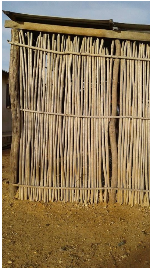
Figura 5. Yotojoro empleado para la construcción de la vivienda wayuu, 2016.
