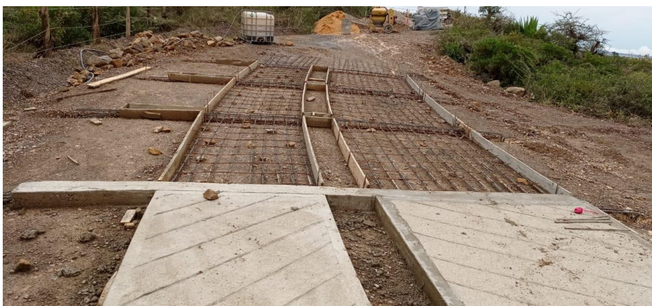
Figura 15: Instalación de separadores para garantizar recubrimientos.
