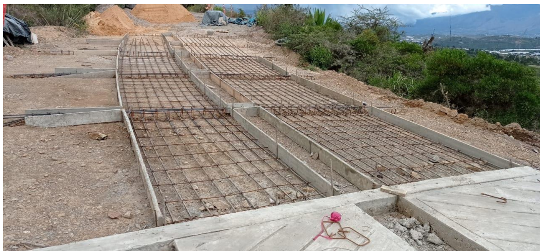
Figura 10: Traslapos Acero de refuerzo - Tramo Cañón 3. Fuente: Autor.
