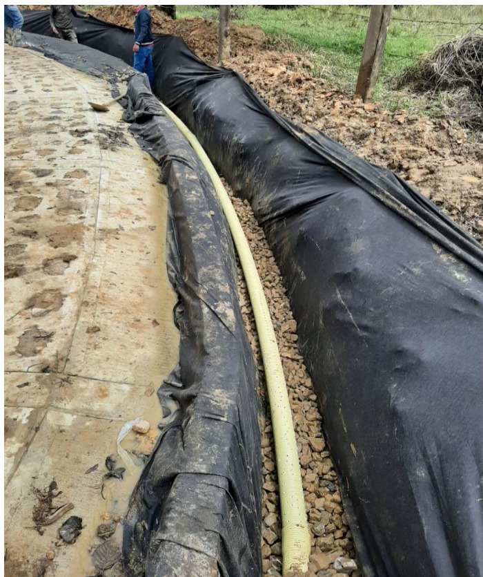
Figura 19: Instalación de filtro en Tramo Volcán 2. Fuente: Autor
