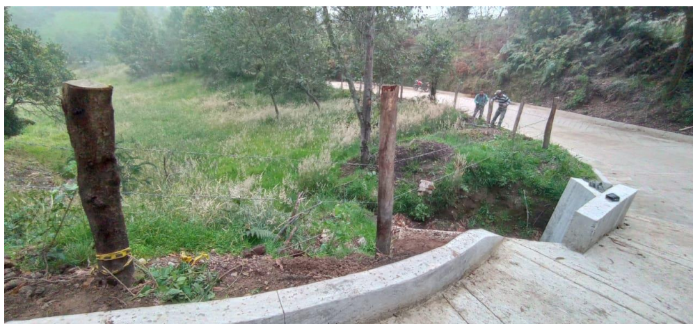
Figura 21: Realización de cercas en predios aledaños. Fuente: Autor.
