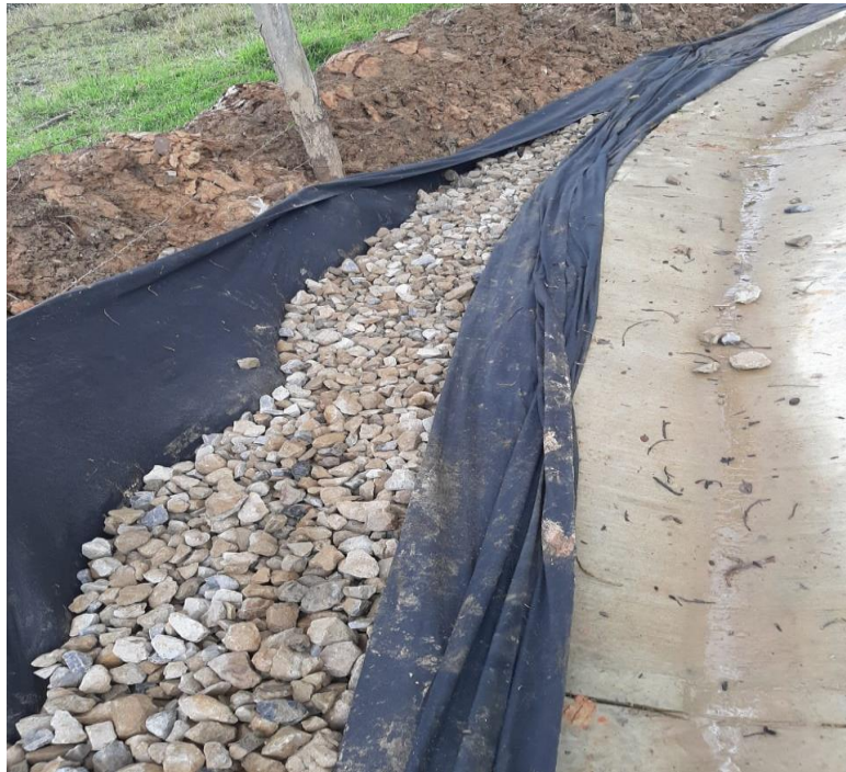
Figura 20: Instalación de filtro en Tramo Volcán 2. Fuente: Autor
