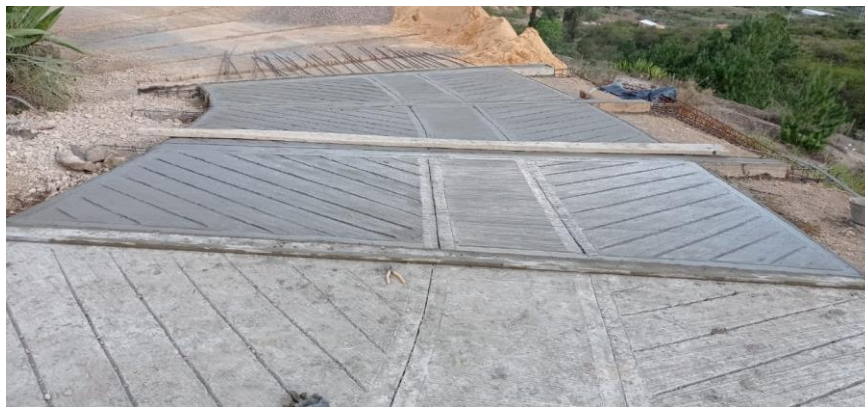
Figura 18: Proceso de fundido de concreto en módulos de huella. Fuente: Autor
