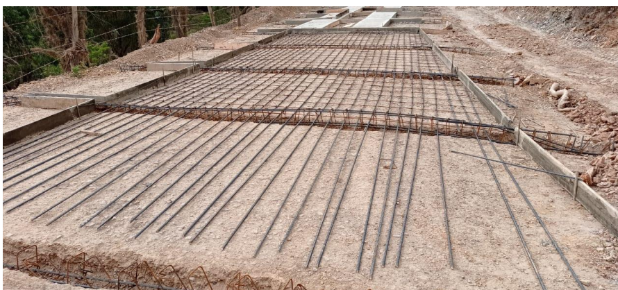
Figura 8: Traslazos Acero de refuerzo - Tramo Cañón 3. Fuente: Auto
