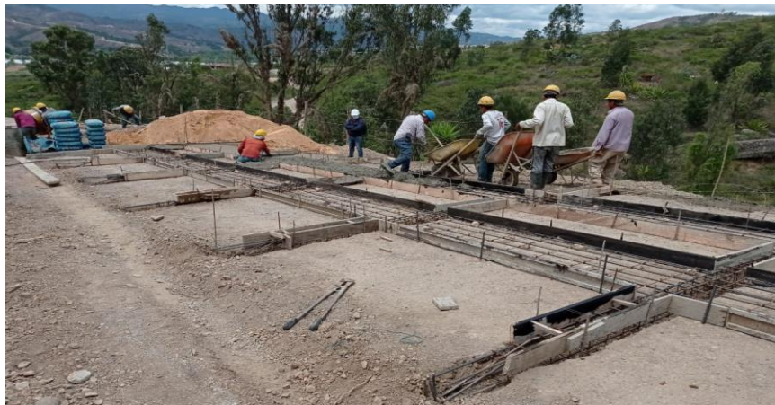
Figura 17: Proceso de fundido de concreto en módulos de huella. Fuente: Autor
