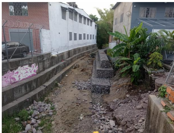
Figura 2. Detalle del cauce de la quebrada en el costado oriental del Anillo vial, en temporada seca. En esta imagen se observa que el cauce ha sido canalizado.
