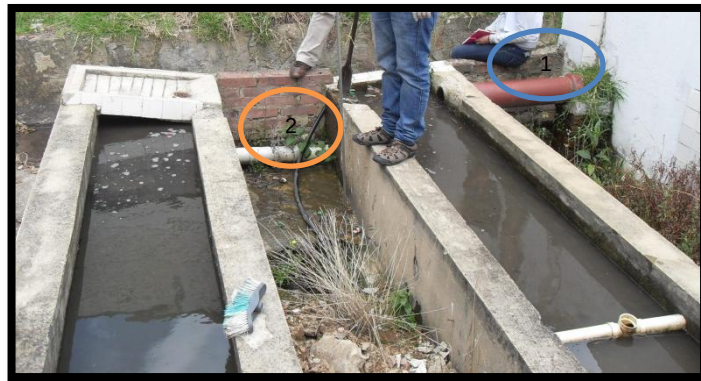
Ilustración 25 Desarenadores del sistema de tratamiento
