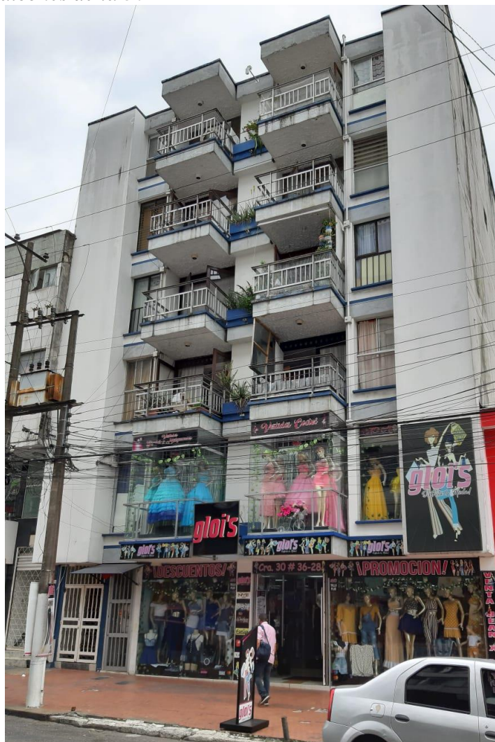
Figura 7. Edificio Balcones de la 30
