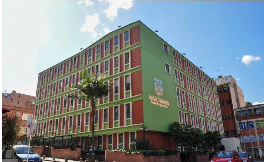
Figura 3. Edificio facultad de ingeniería civil Universidad La Gran Colombia
