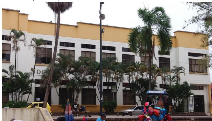
Figura 1. Edificio Nacional (DIAN)
