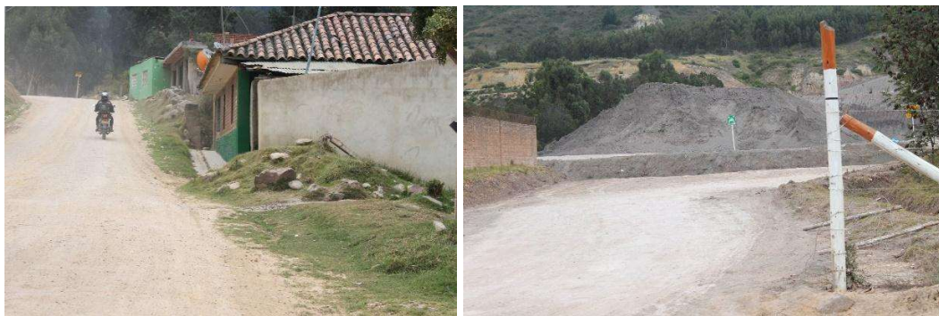
Imagen 18 y 19. Estado de la vía principal debido al constante paso de volquetas y camiones de carga. Fuente propia año 2018.
