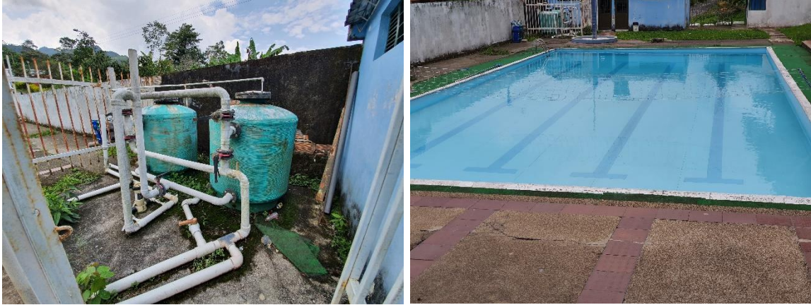
Imagen 2: Piscina Municipal con sus respectivos tanques de mantenimiento.
