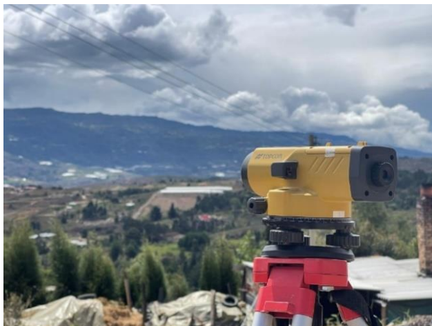
Imagen 33: Levantamiento del perfil topográfico y ubicación de acometidas domiciliarias.
