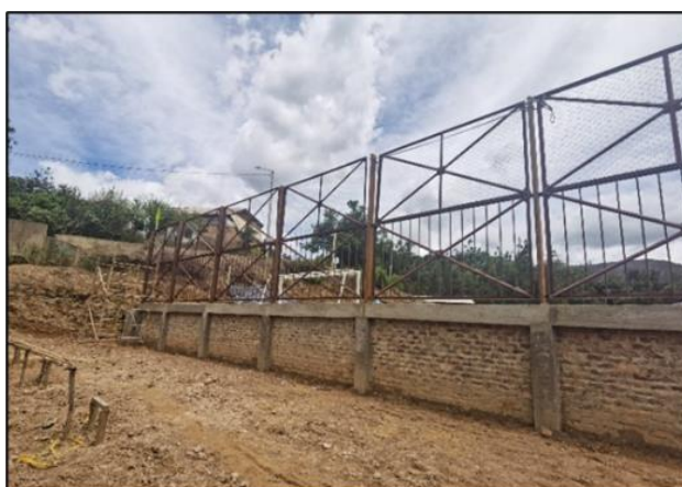
Imagen 27: Finalización del proceso de instalación de los módulos de cerramiento.
