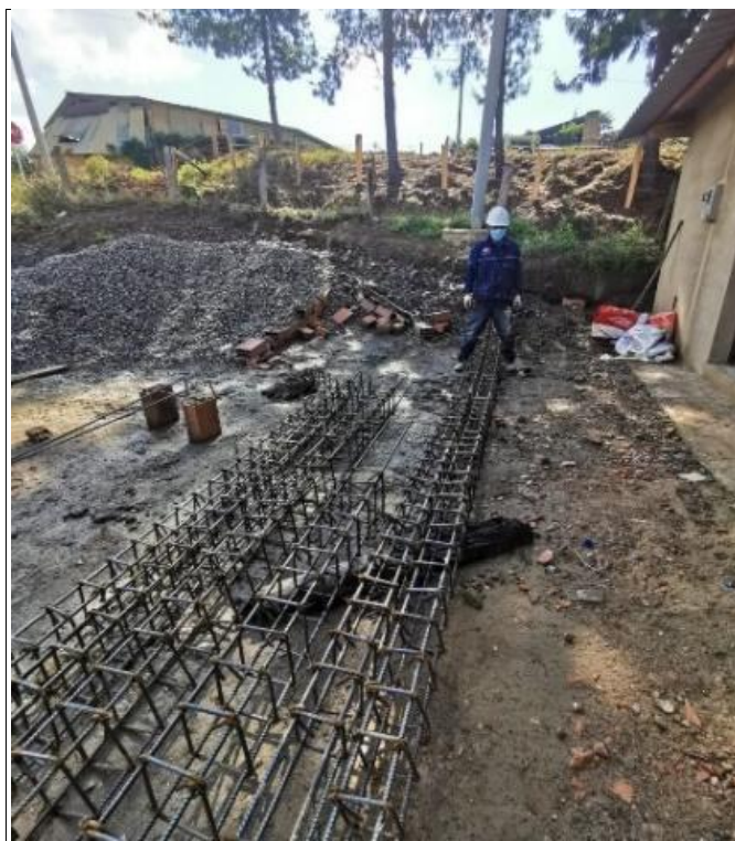
Imagen 6: Figurado acero de refuerzo
