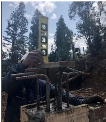
Imagen 14: verificación de niveles de pernos para módulos de cerramiento
