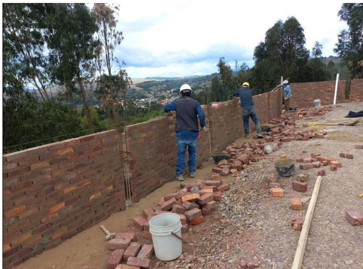
Imagen 11: Construcción de muro perimetral en mampostería.
