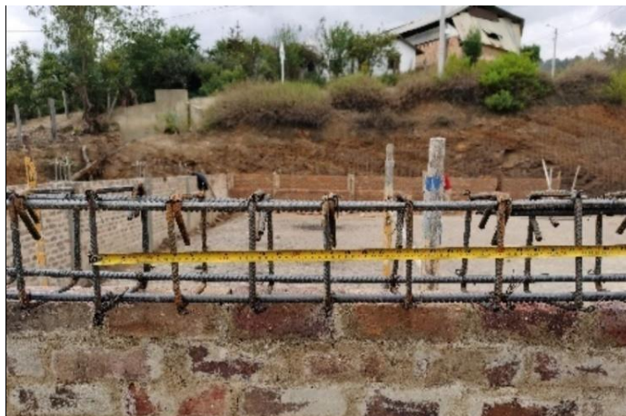
Imagen 16: Acero de viga de amarre sobre muro
