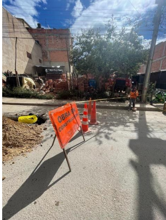
Imagen 35: Señalización de obra.
