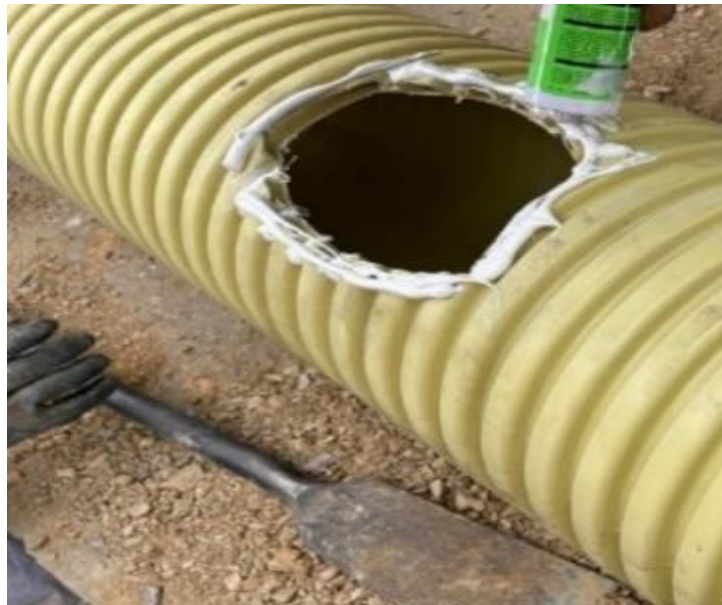
Imagen 55: Reparación de acometidas domiciliarias.
