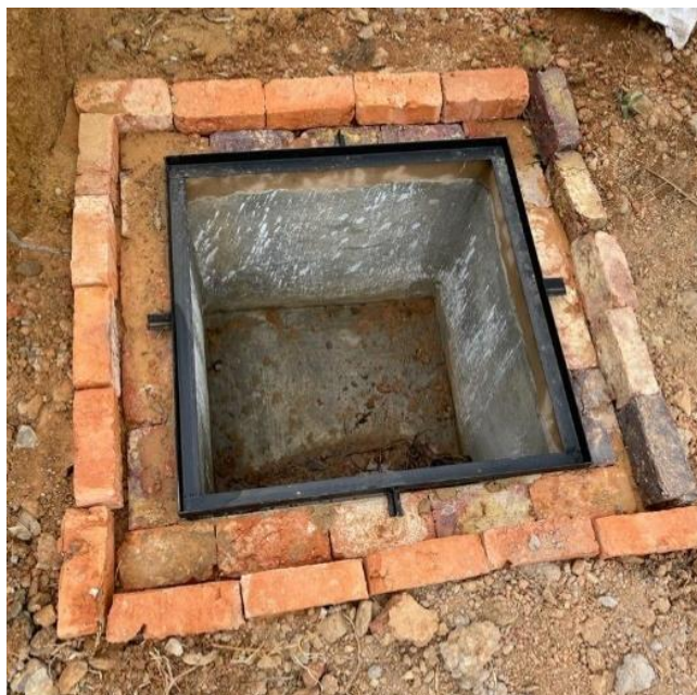
Imagen 43: Construcción de cajas de inspección.
