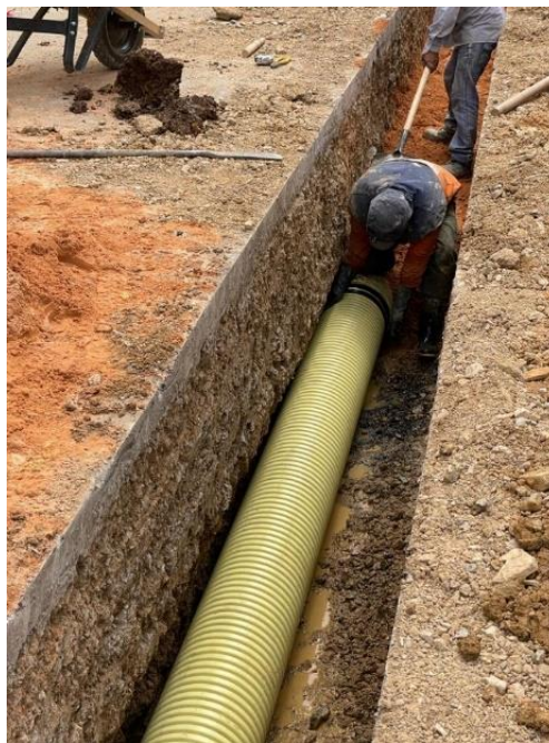
Imagen 53: instalación de tubería.
