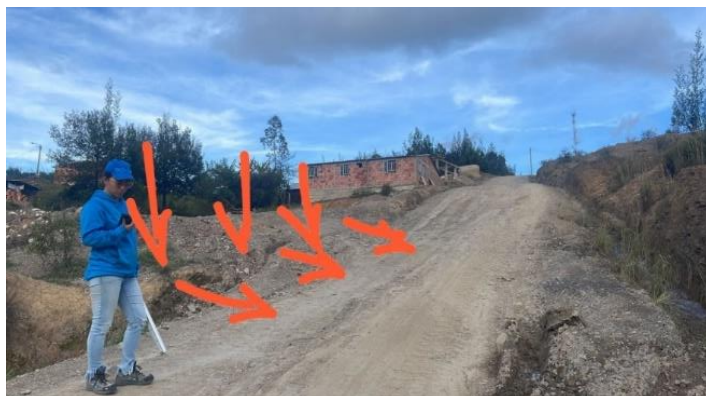
Imagen 34: Registro fotográfico para ubicación de acometidas domiciliarias.
