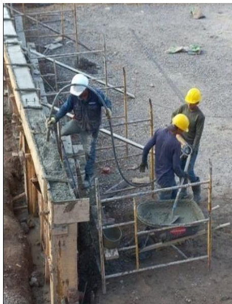
Imagen 18: Fundida de viga de amarre sobre muro.
