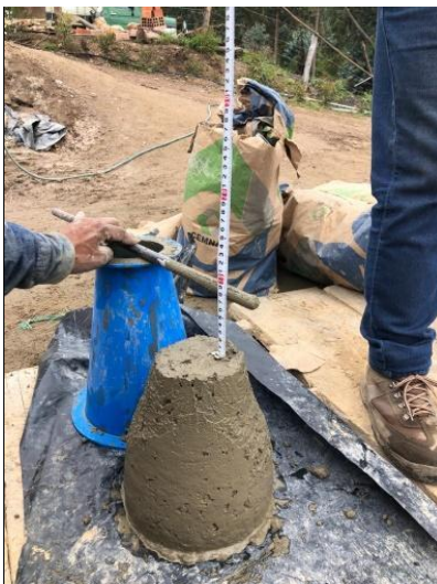
Imagen 20: Elaboración de ensayo de asentamiento para concreto de viga de amarre sobre muro.
