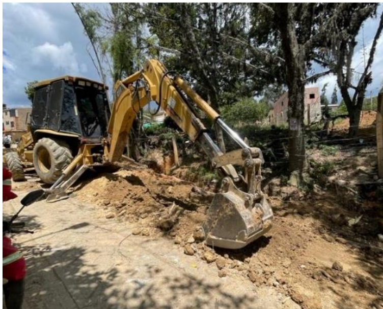
Imagen 37: Excavación mecánica para tramo 1
