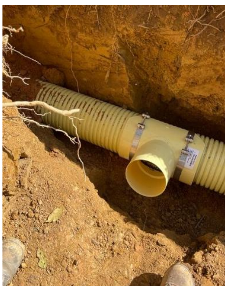
Imagen 40: Instalación de acometidas
