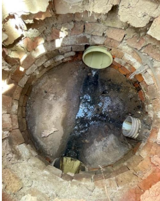
Imagen 59:verificación de correcto funcionamiento del tramo: 2) pozo final
