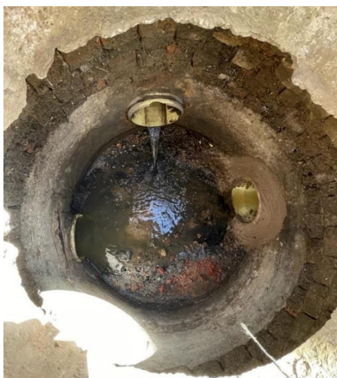
Imagen 58:verificación de correcto funcionamiento del tramo: 1) pozo inicial.
