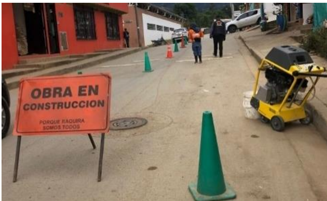
Imagen 48: Señalización de obra.
