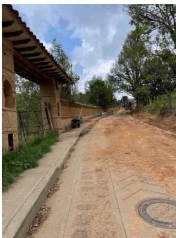
Imagen 42: Limpieza de vía.
