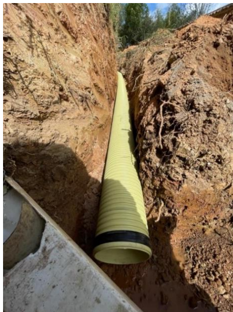
Imagen 39: Instalación tubería tramo 1.
