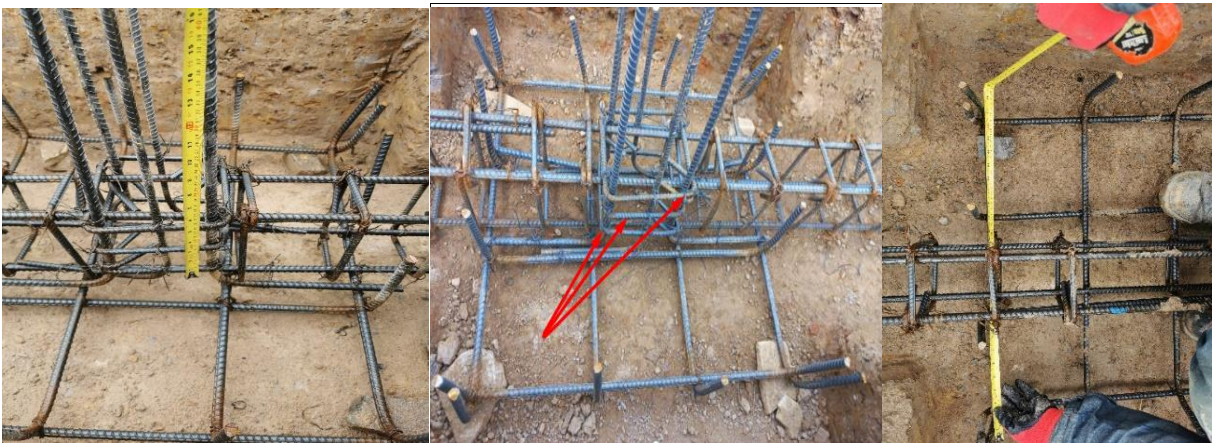
Imagen 8: verificación en campo de suministro y amarre de acero de refuerzo
