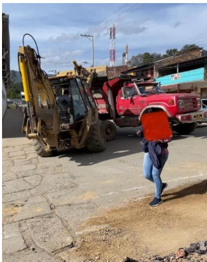
Imagen 57: Retiro de material sobrante de excavación.
