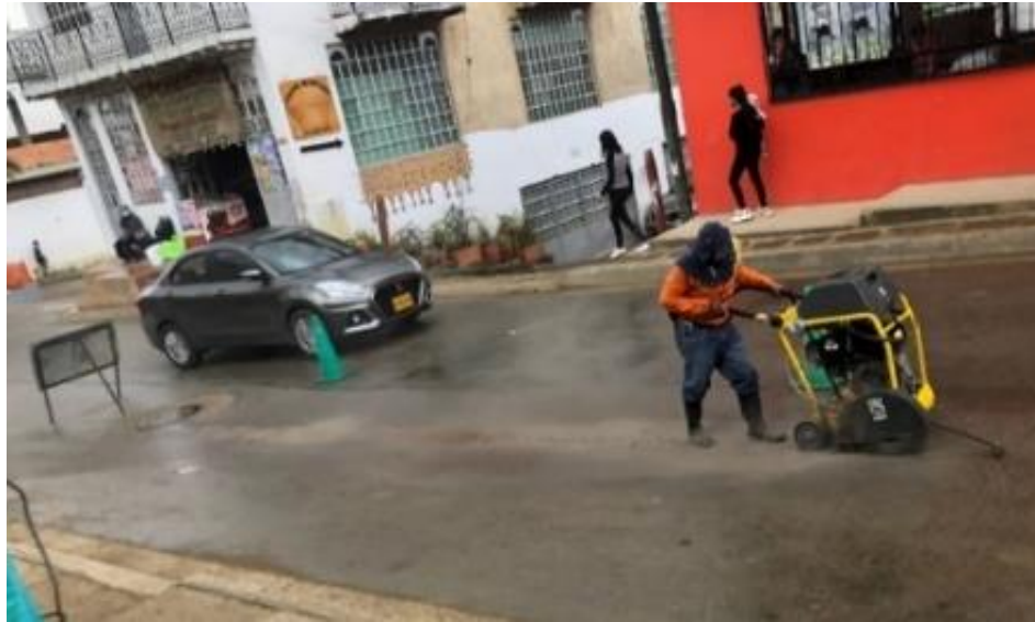
Imagen 49: Demarcación y corte de carpeta asfáltica. Fuente: Autor.
