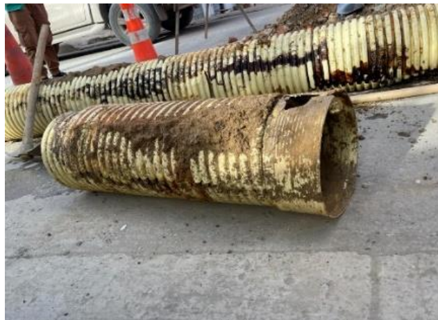
Imagen 52: Retiro de tubería.
