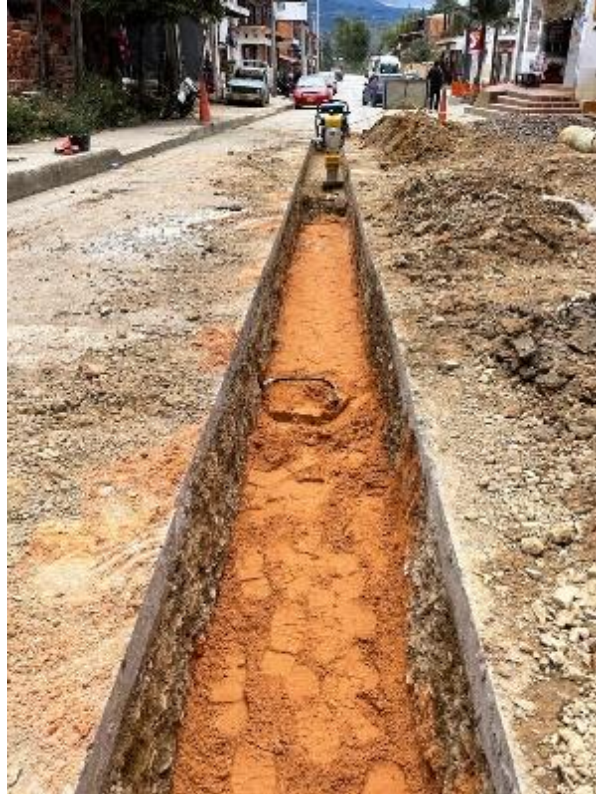
Imagen 54: instalación de tubería.
