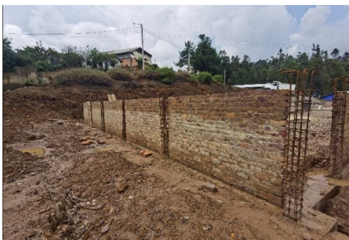
Imagen 12: Suministro, colocación y amarre de acero de refuerzo columnas.
