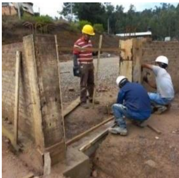
Imagen 13:Encofrado de columnas
