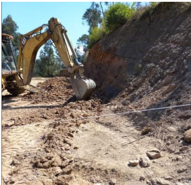
Imagen 4:Excavación mecánica zona de mejoramiento cerramiento, graderías, placa de piso.
