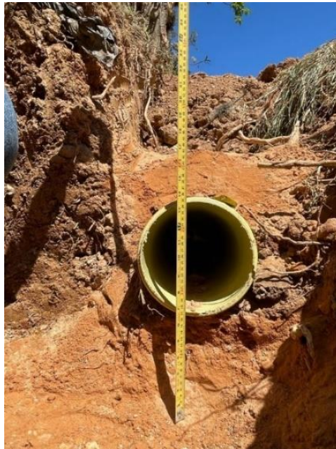
Imagen 38: Cimentación y relleno inicial para tubería tramo 1.
