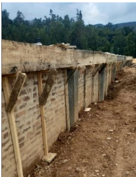
Imagen 17: Encofrado de viga de amarre sobre muro.
