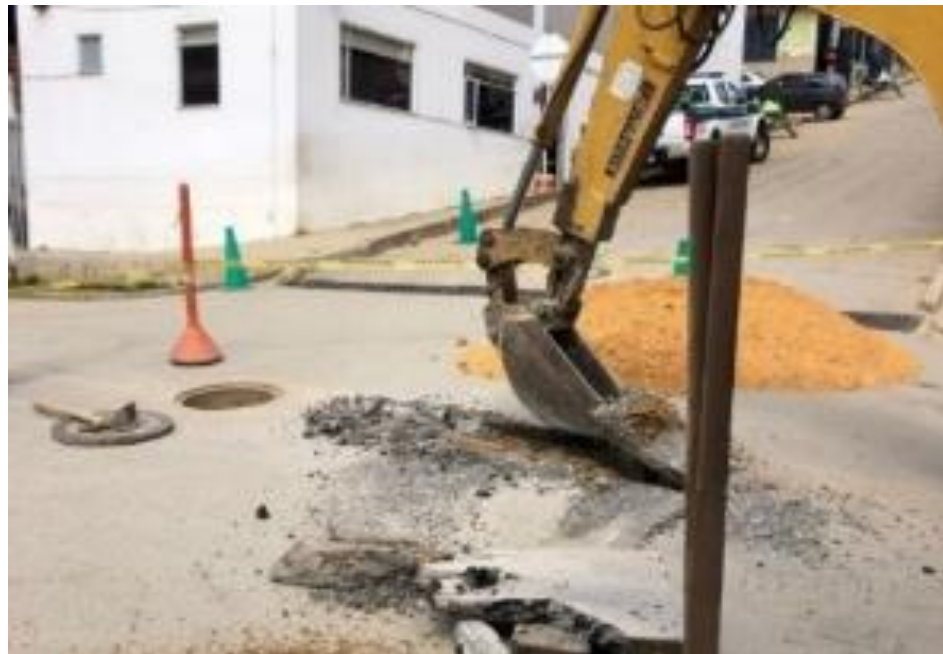
Imagen 50: Demolición y retiro de carpeta asfáltica. Fuente: Autor.
