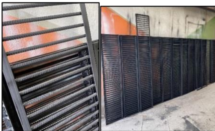
Imagen 28: Construcción de rejillas para cárcamo.
