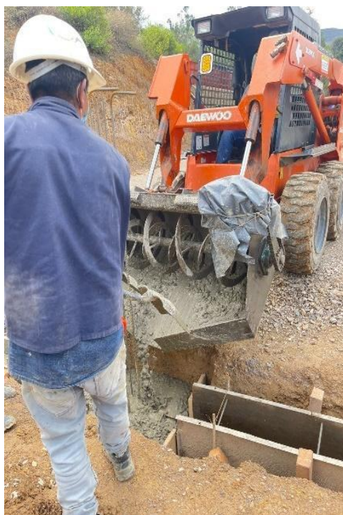
Imagen 9: Vaciado de mezcla
