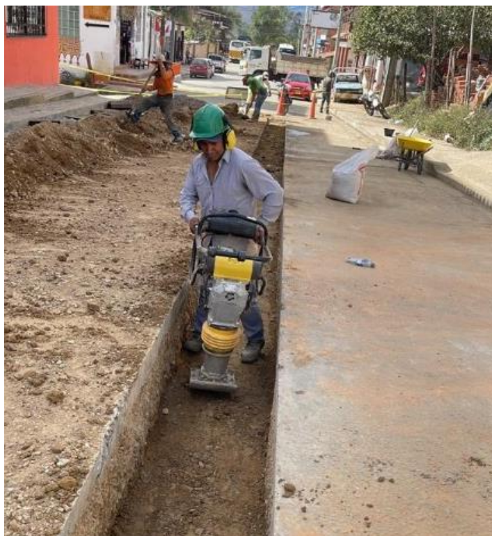
Imagen 56: Extendido y compactación de subbase granular.
