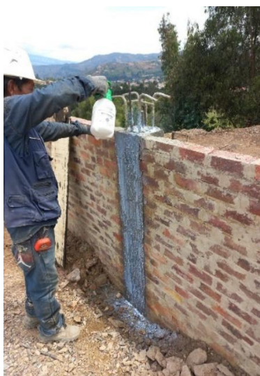
Imagen 15:Desenfofrado y curado de concreto columnas.
