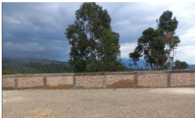
Imagen 21:Desencofrado y curado de viga de amarre sobre muro.
