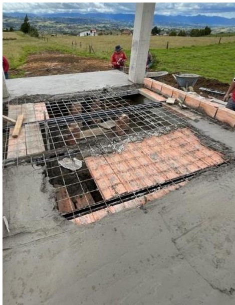
Imagen 46: Segunda visita de obra Chivata- Boyacá.
