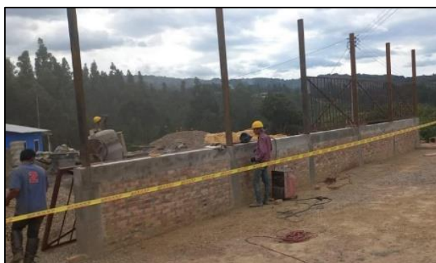
Imagen 26: Proceso de instalación de módulos de cerramiento.
