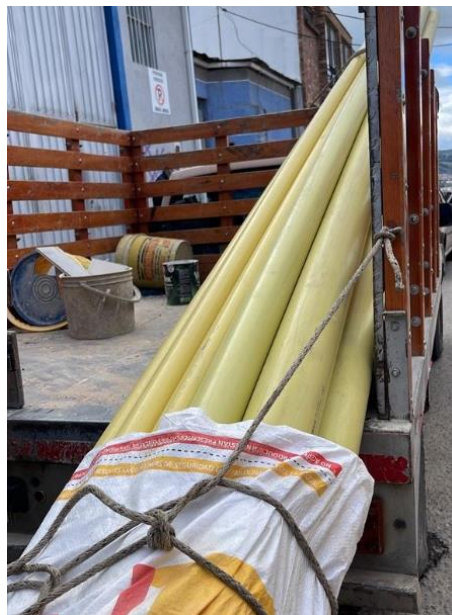
Imagen 44: Compra y transporte de materiales de obra casa campestre Chivata-Boyacá.
