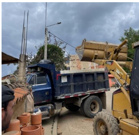
Imagen 41: Limpieza de vía.
