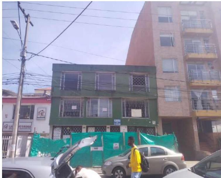
Figura 2. Fachada del proyecto- vivienda multifamiliar barrio Spring. Fuente Propia.
