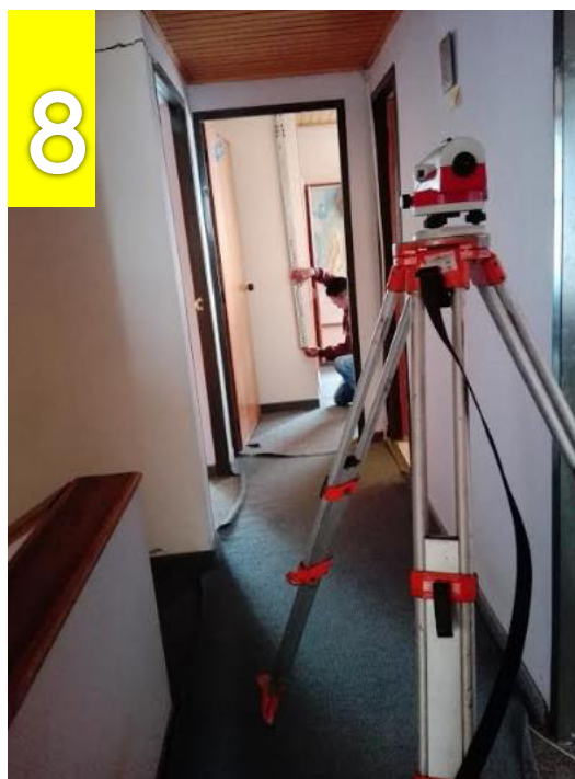
Fotografía 5: Toma de Puntos de nivel de placa segunda planta
