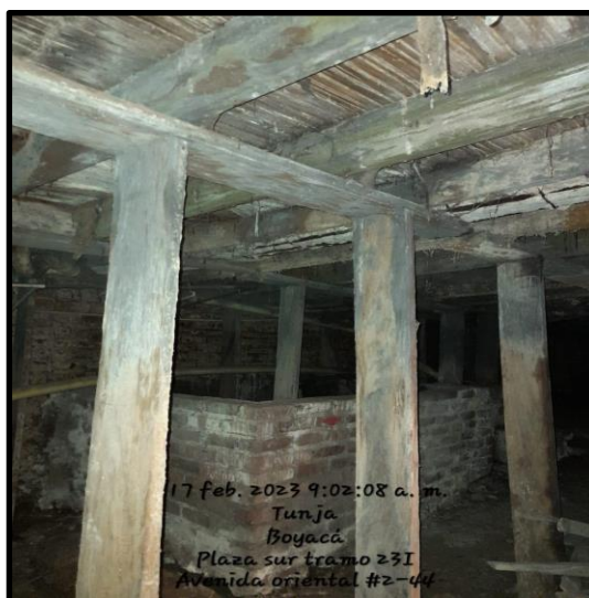
Figura 4. Columnas de predio en Av. Oriental #2-44
