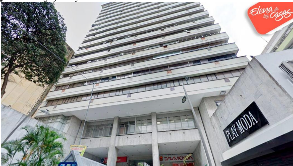
Figura 10. Fotografía Edificio José Acevedo Gómez Fachada Frontal Carrera 35.
