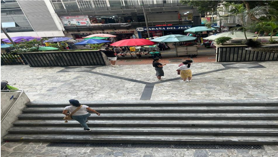
Figura 1. Deterioro e informalidad paseo del comercio.
